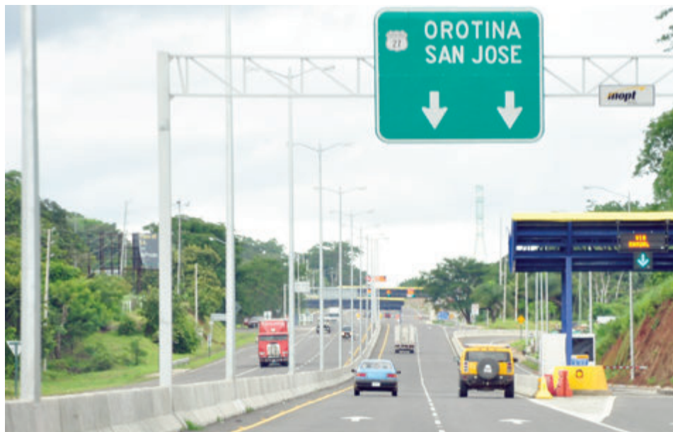
▲ RUTA 27. La carretera San José- Caldera se terminó de construir en 2010 y funciona bajo el modelo de concesión.
