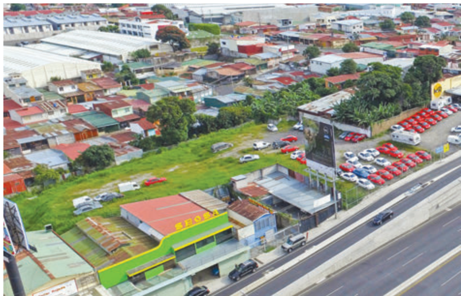
▲ CALZADA ELEVADA. Mejoras importantes en la vialidad del casco urbano como el paso elevado en la Rotonda de Paso Ancho.
