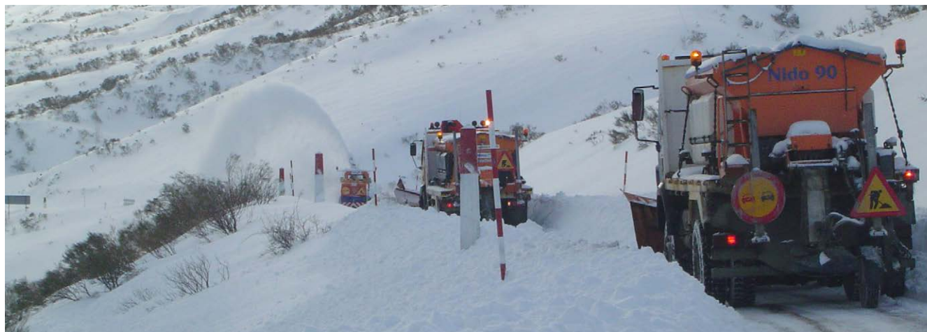
Trabajos de conservación y mantenimiento.
