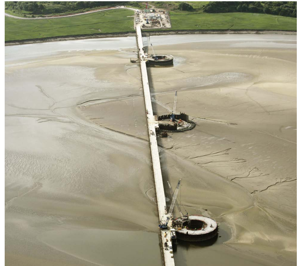
Puente de Mersey (Reino Unido).
