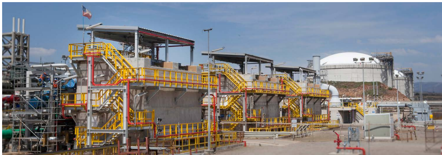
Planta de regasificación de GNL. Quintero (Chile).
