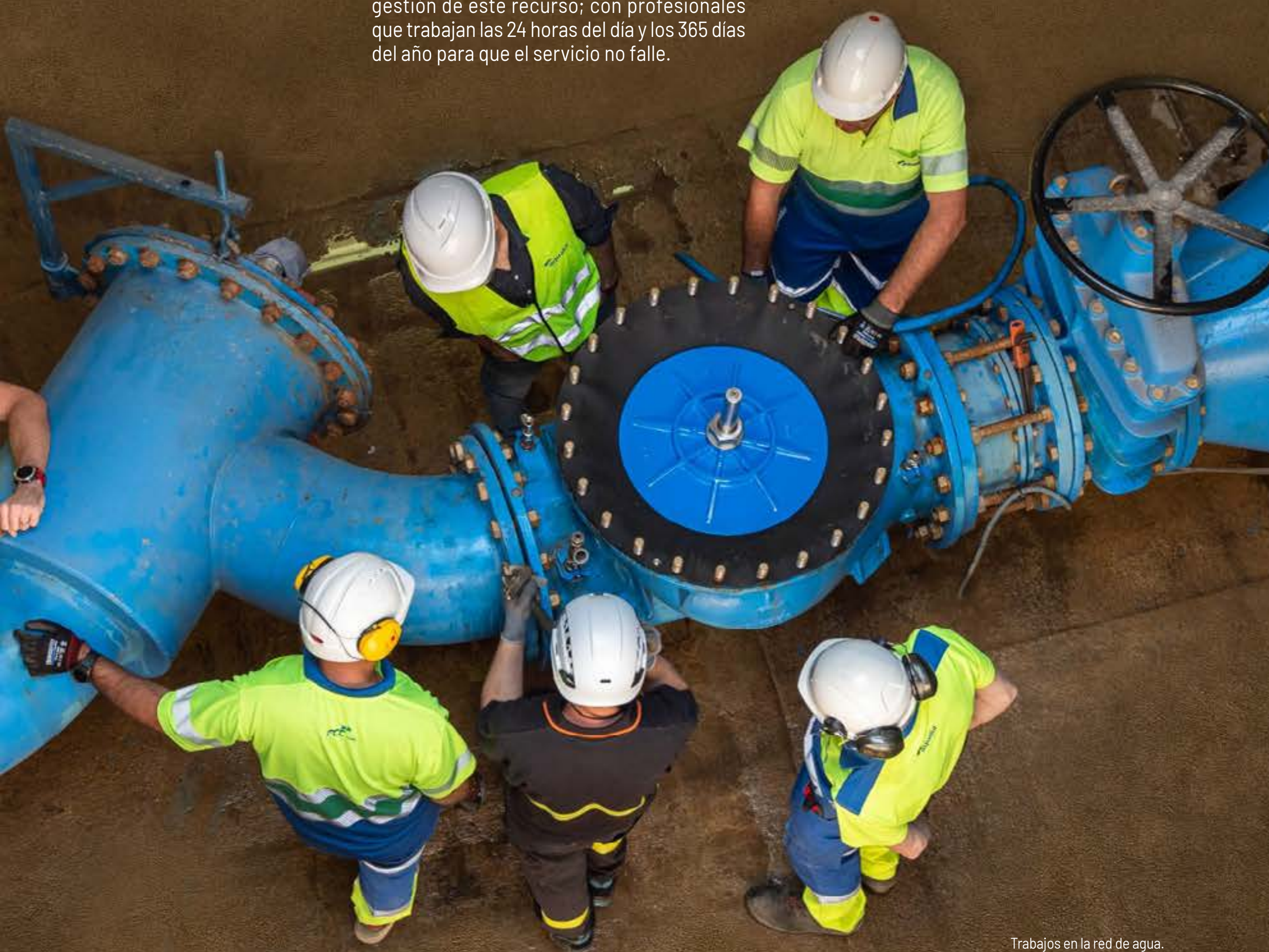
Trabajos en la red de agua.
