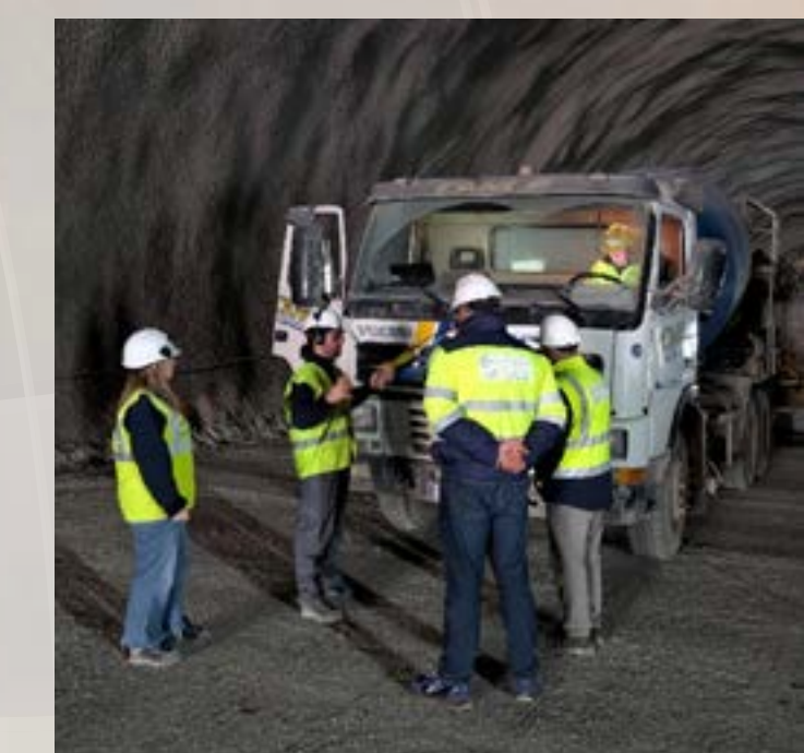
Pruebas realizadas en el Túnel de Tenerife de FCC Construcción.
