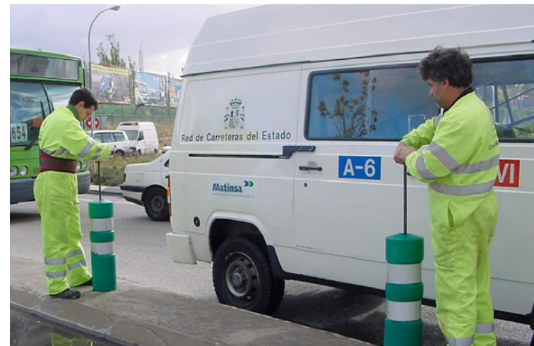
Colocación de bolarlo flexible
