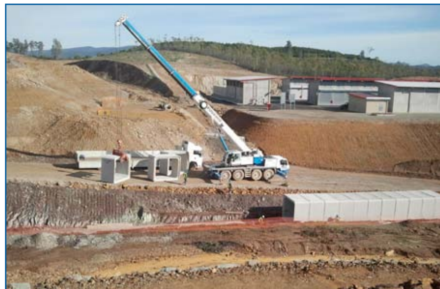
Colocación de estructuras modulares de hormigón armado.
