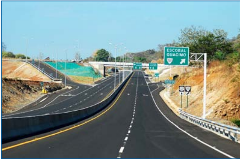
Autopista San José Caldera, Costa Rica
