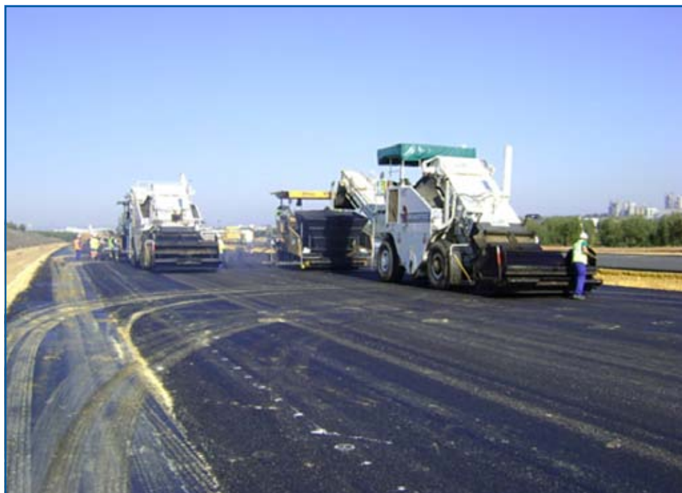
Obras de Carreteras y Hormigones
