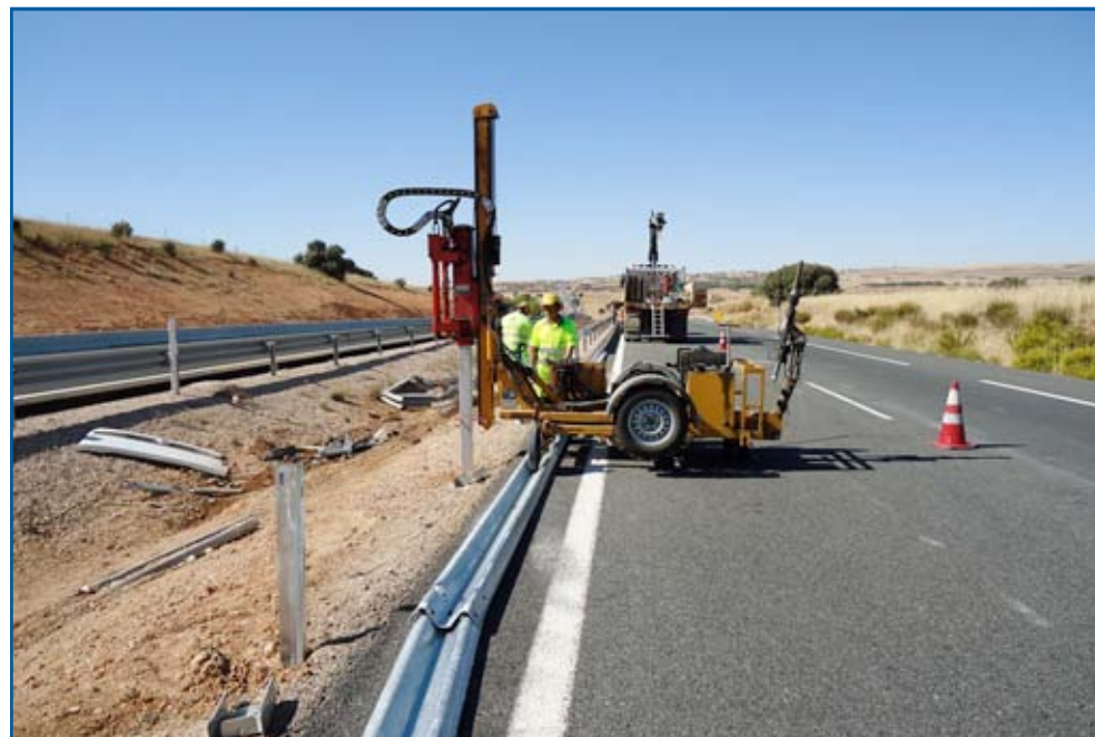
Colocación de vallas protectoras en autopistas
