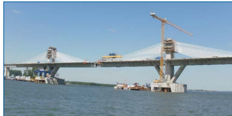
Puente Vidin-Calafat (Bulgaria-Rumanía)
