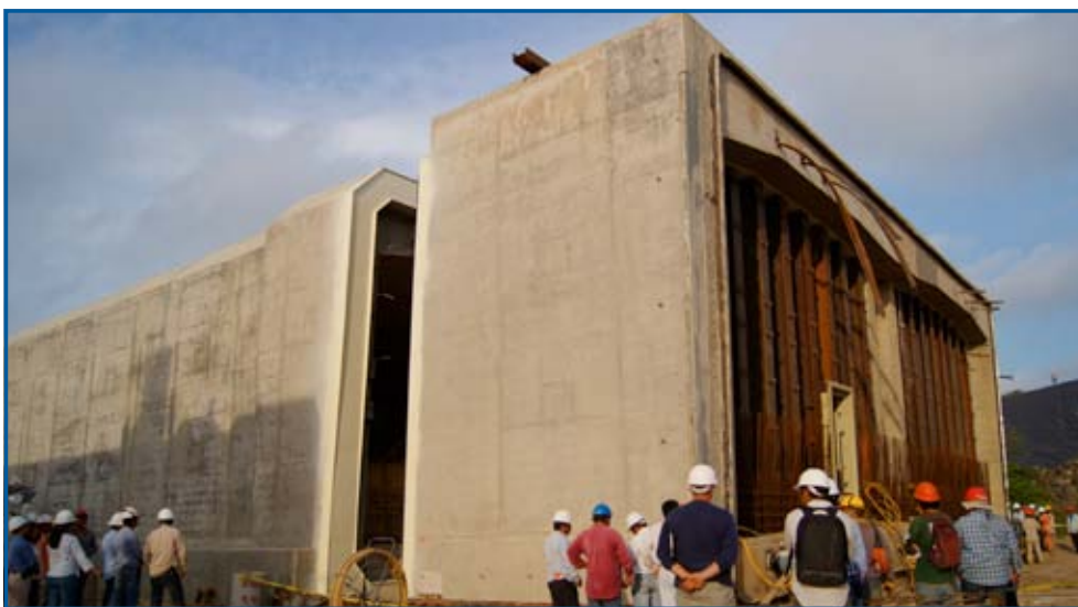
Túnel de Coatzacoalcos (México)
