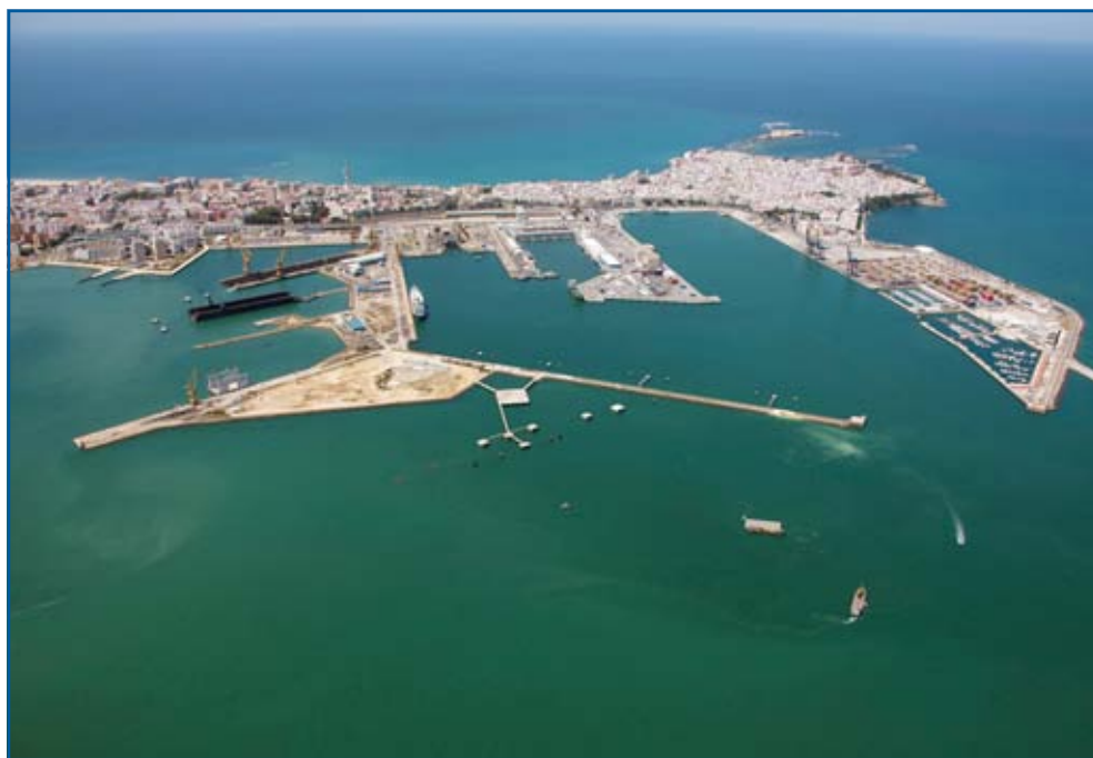
Terminal de contenedores del puerto de Cadiz
