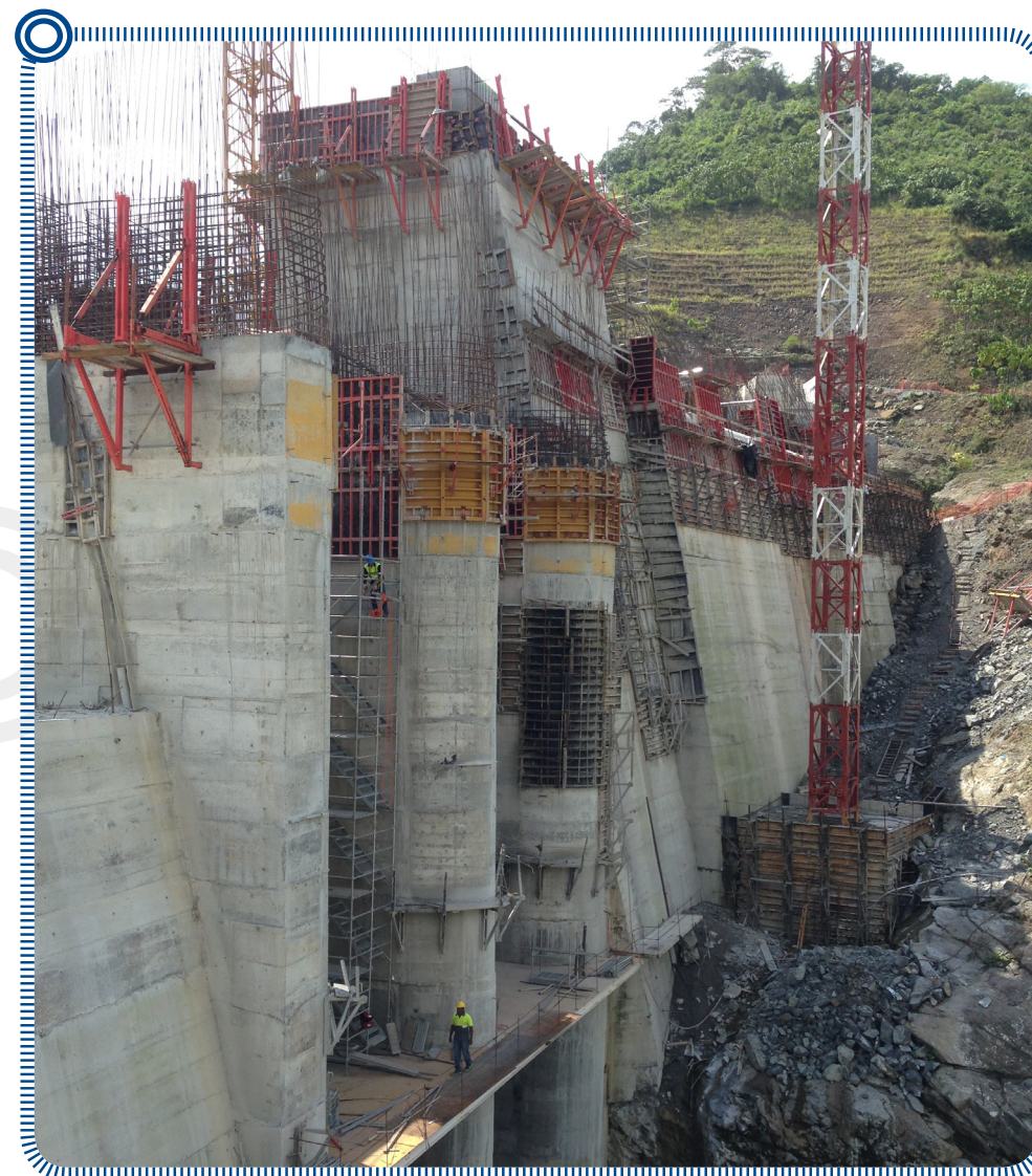
Presa de Bajo Frío (Panamá)
