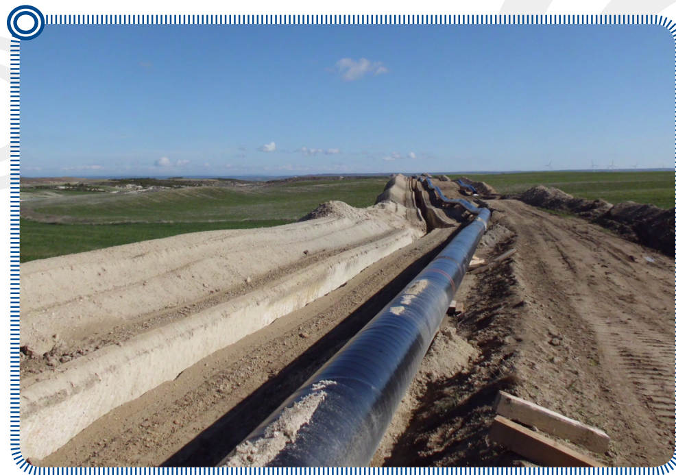
Gasoducto Yela-Villar de Arnedo
