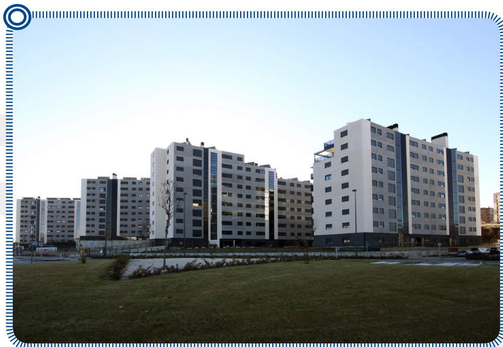
Nuevas viviendas en la Urbanización Nuevo Tres Cantos, Madrid
