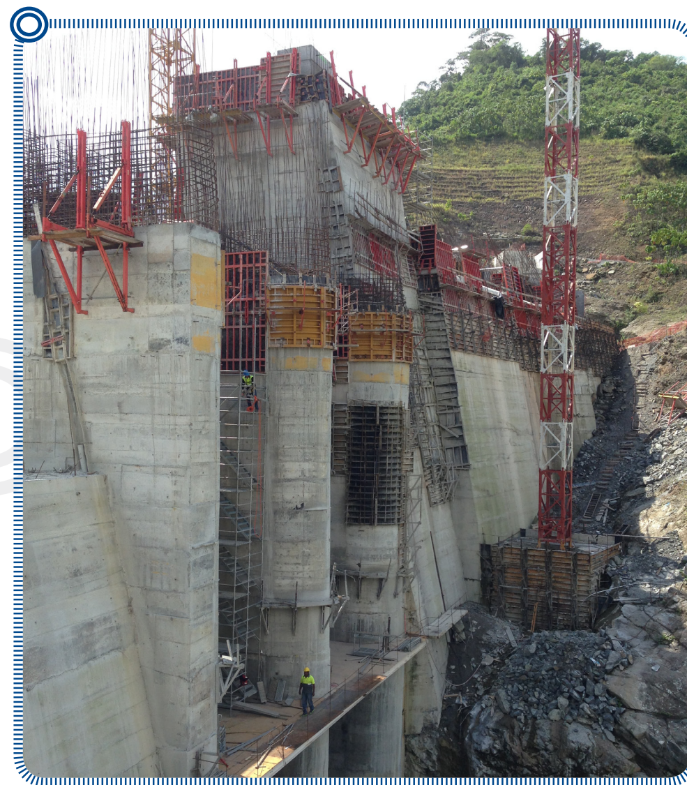
Presa de Bajo Frío (Panamá)
