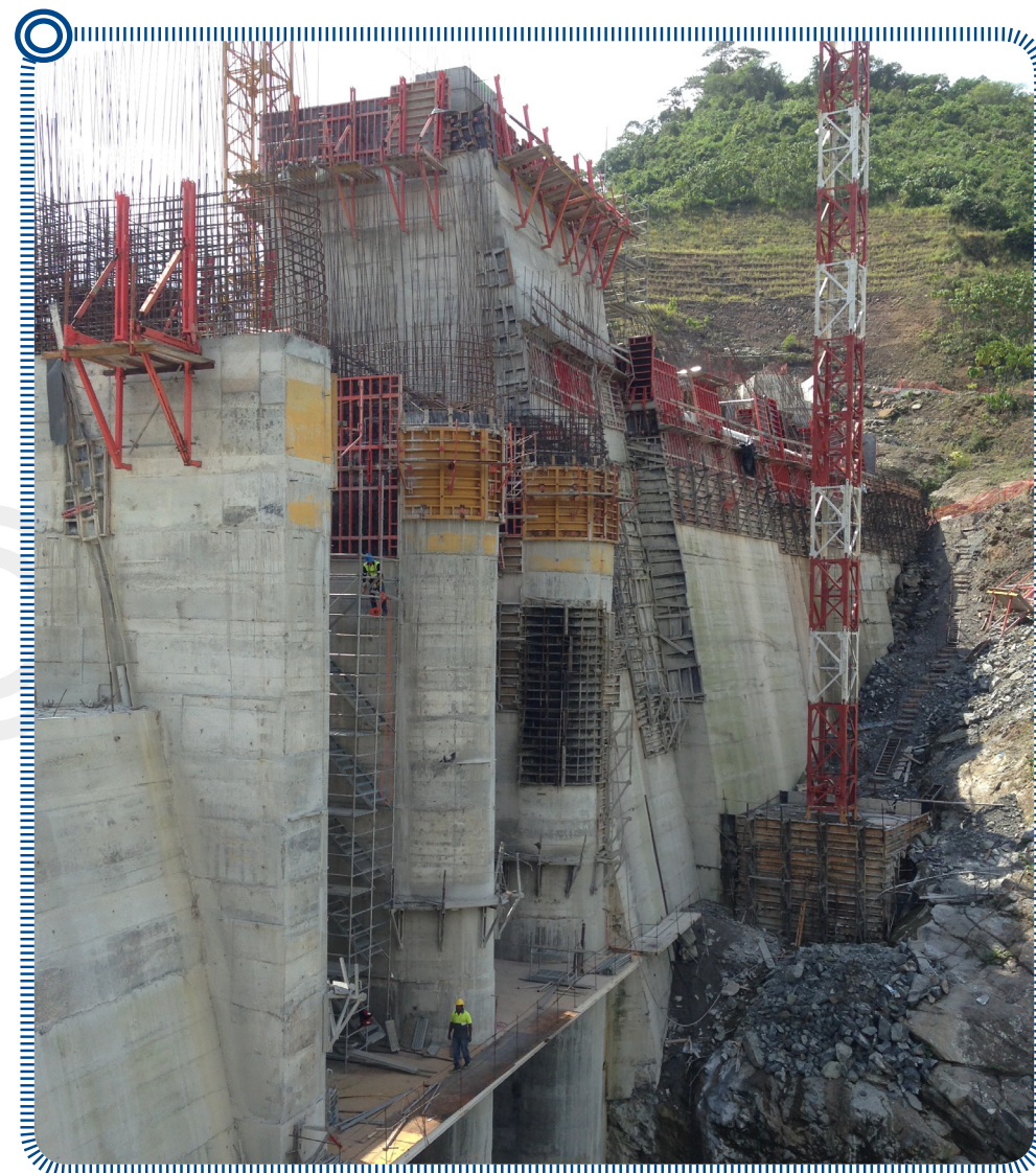
Presa de Bajo Frío (Panamá)
