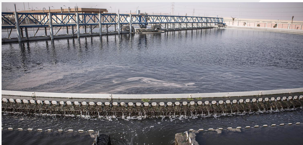
Depuradora New Cairo (Egipto).
