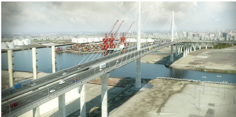
Puente Gerald Desmond, Los Ángeles (EE.UU.).
