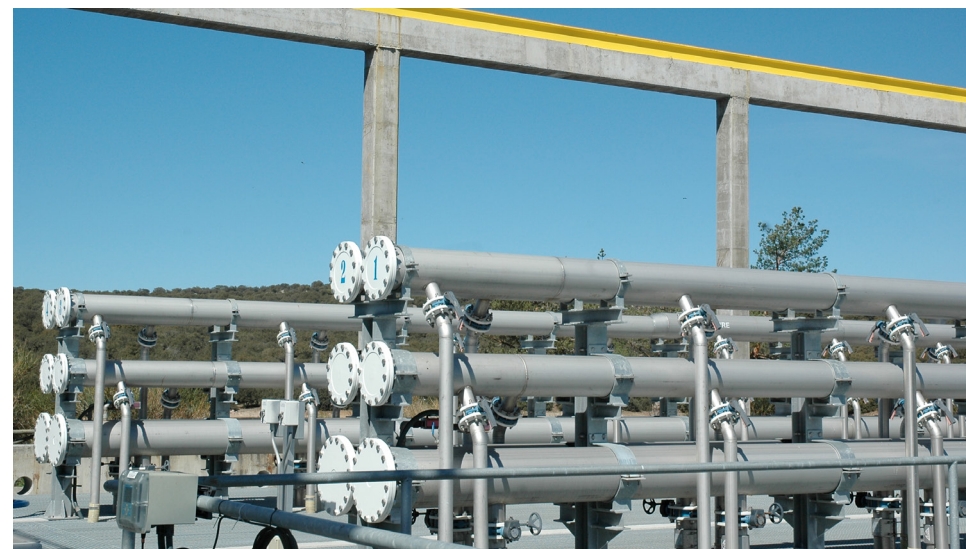
Membranas de fibra hueca.
