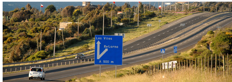
Autopista del Aconcagua (Chile).
