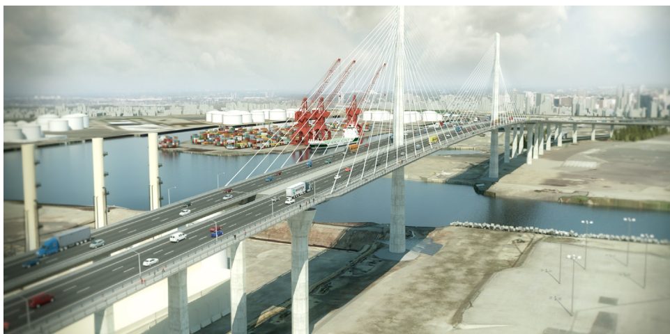
Puente Gerald Desmond, Los Ángeles (EE.UU.).
