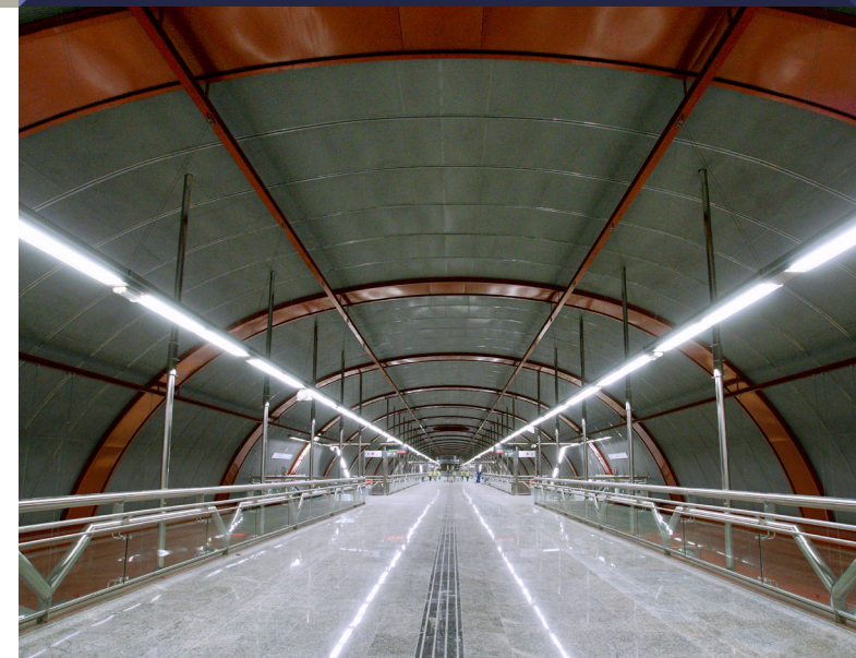
Estación de Cercanías de Sol, Madrid.
