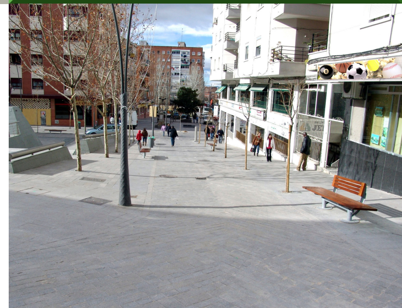
Remodelación de la zona centro Alcorcón, Madrid.
