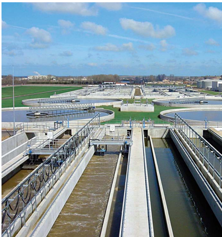
Depuradora de aguas residuales. Salamanca
