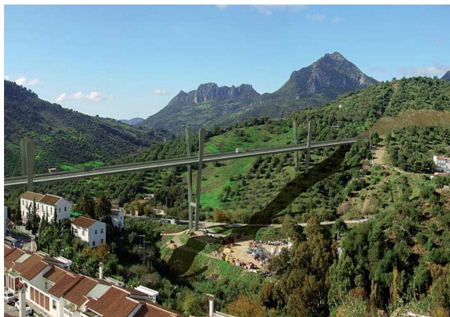
Viaducto variante oeste, Ubrique. Cádiz
