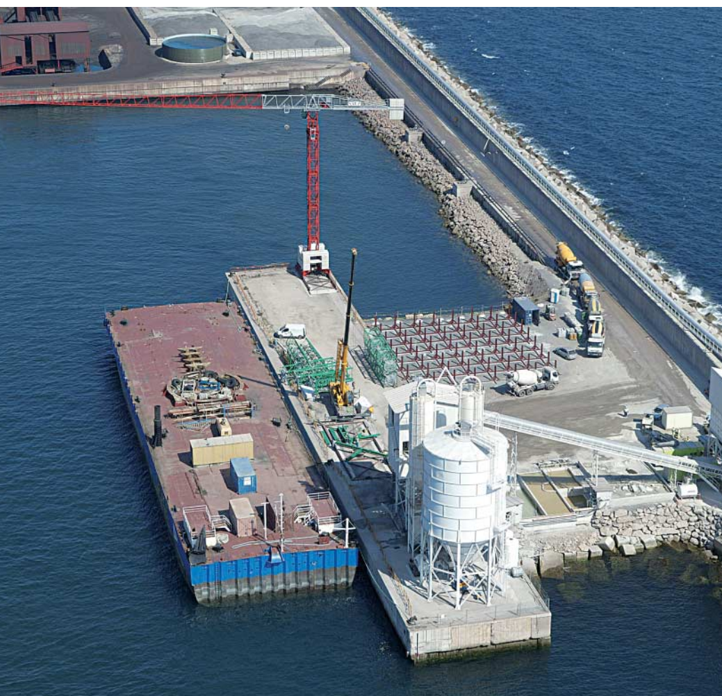
Ampliación del puerto de El Musel. Asturias
