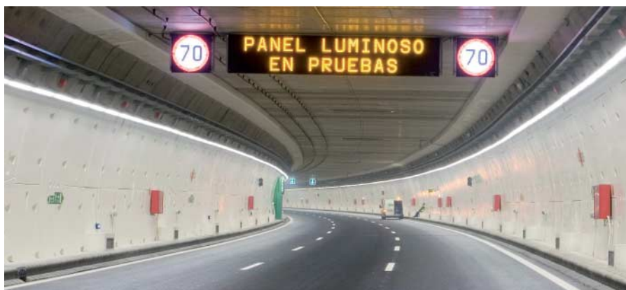
Túnel del by-pass sur de la M-30. Madrid
