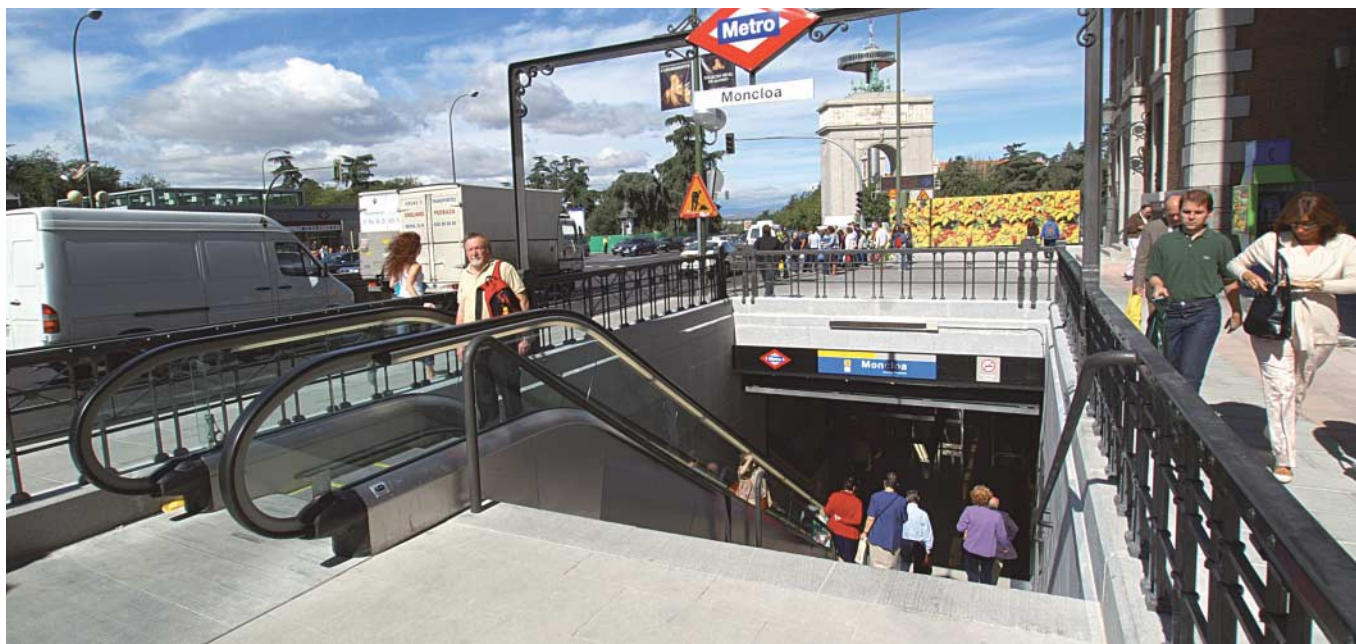
Estación de Metro de Moncloa. Madrid
