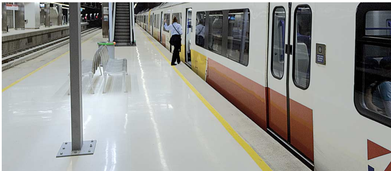
Soterramiento de las líneas del Tren de les Illes Balears, TIB. Palma de Mallorca
