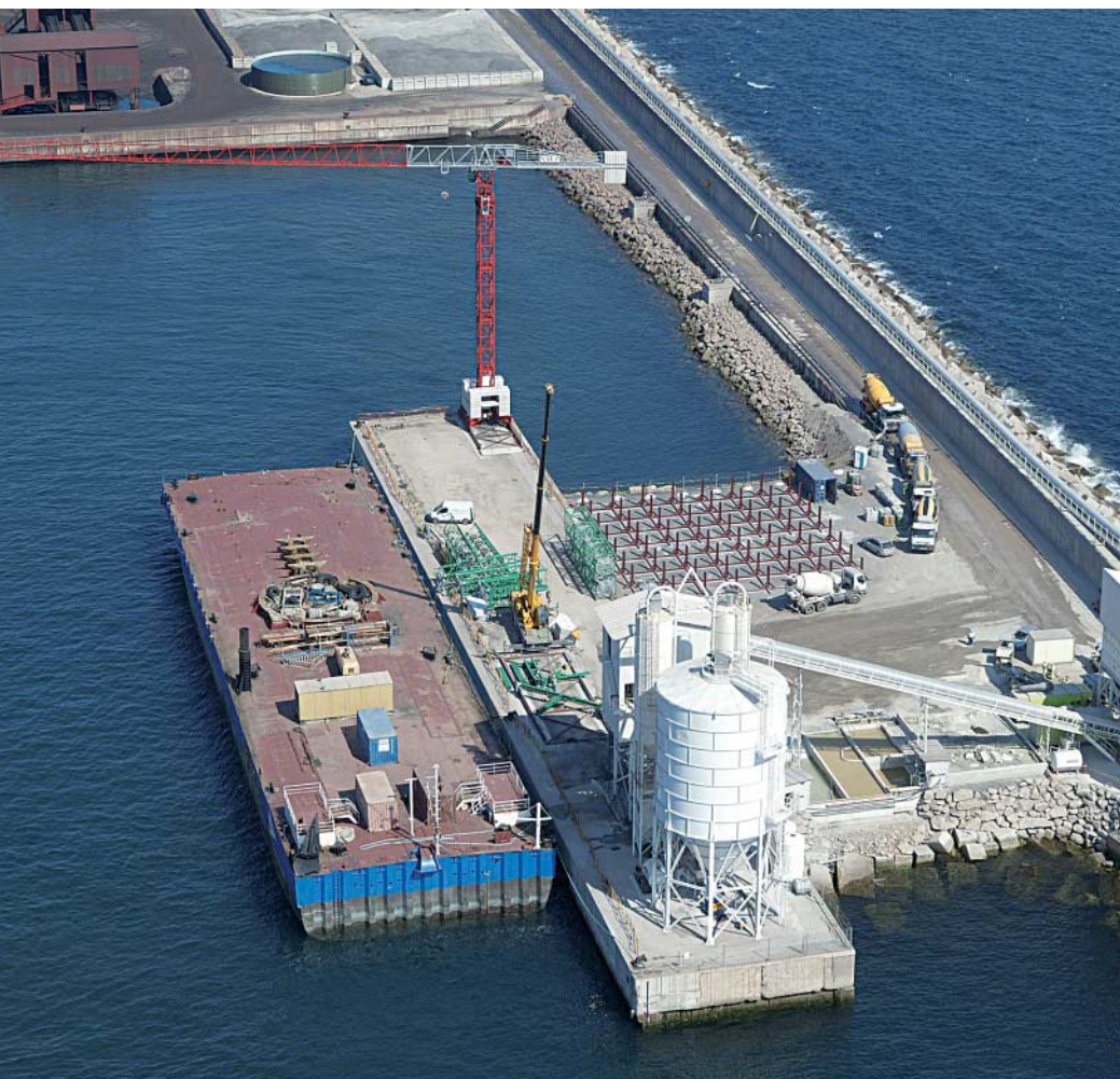
Ampliación del puerto de El Musel. Asturias
