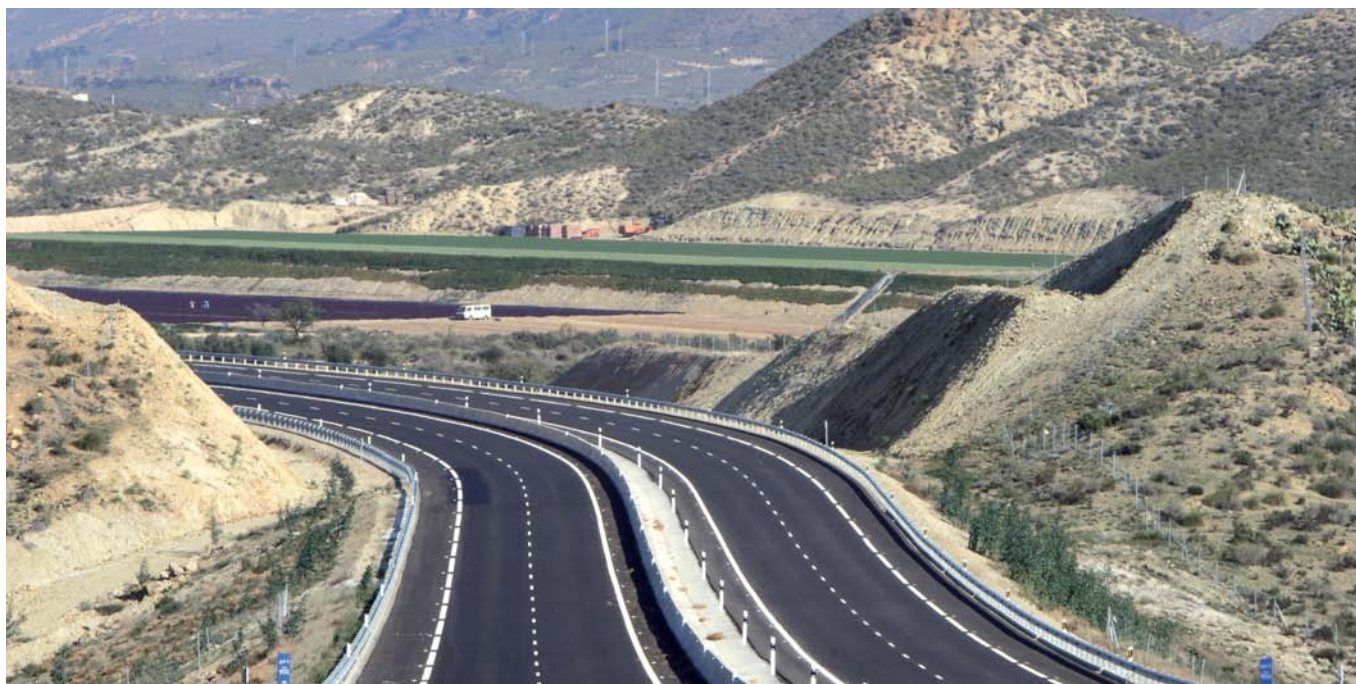
Viaducto de Canero. Autovía del Cantábrico. Tramo Querus-Otur.
