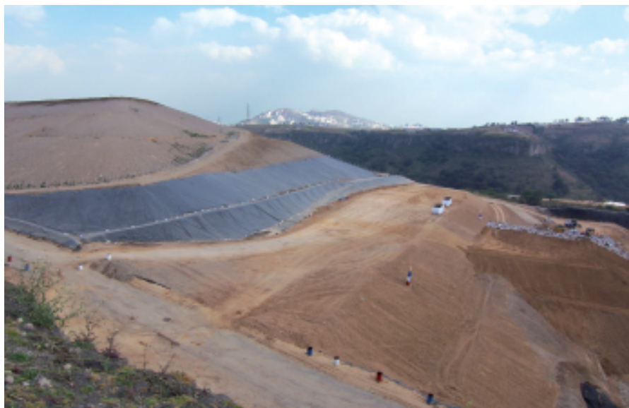
Relleno sanitario en México
