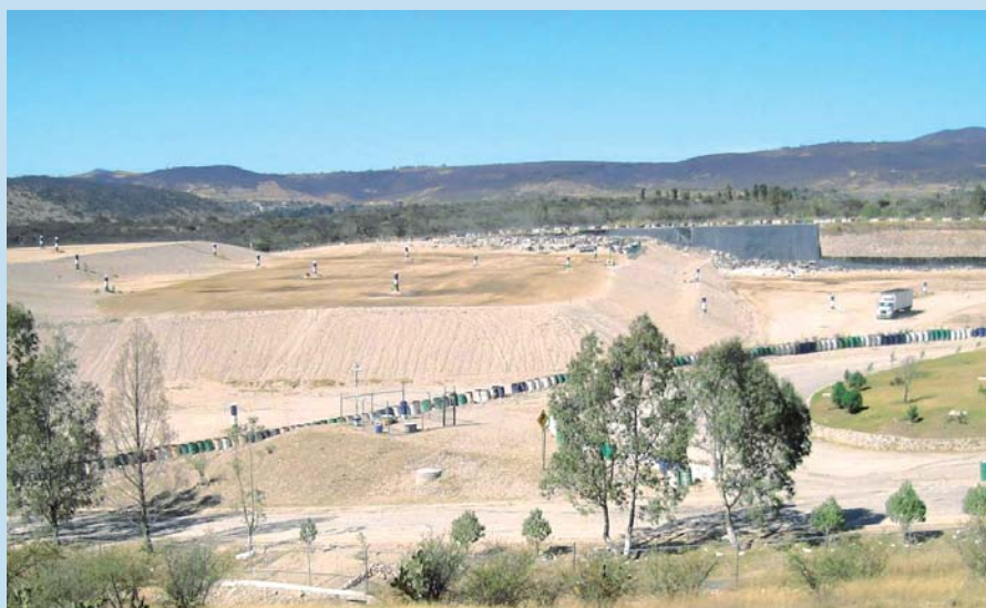
Relleno sanitario de Querétaro
