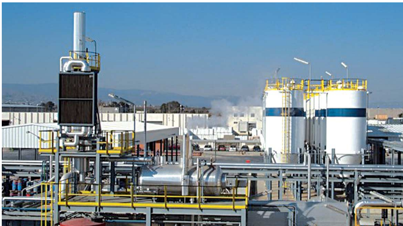
Planta de tratamiento y recuperación de residuos industriales Trisa. Constanti. Tarragona
