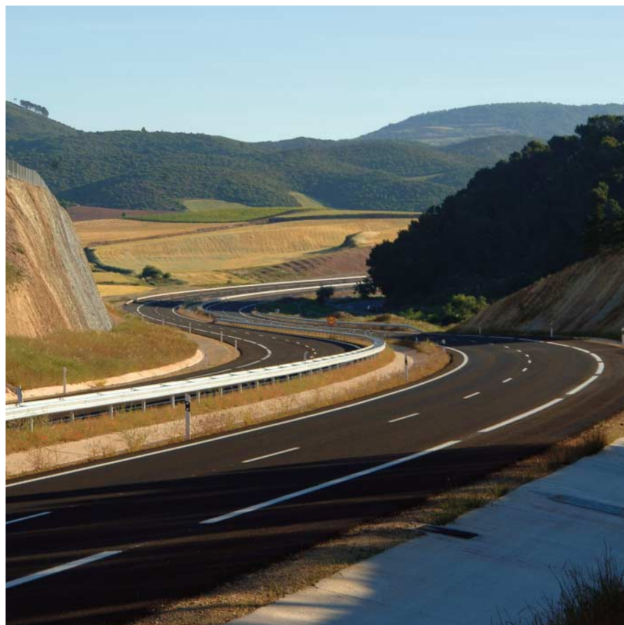
Autovía del Camino. Pamplona-Logroño
