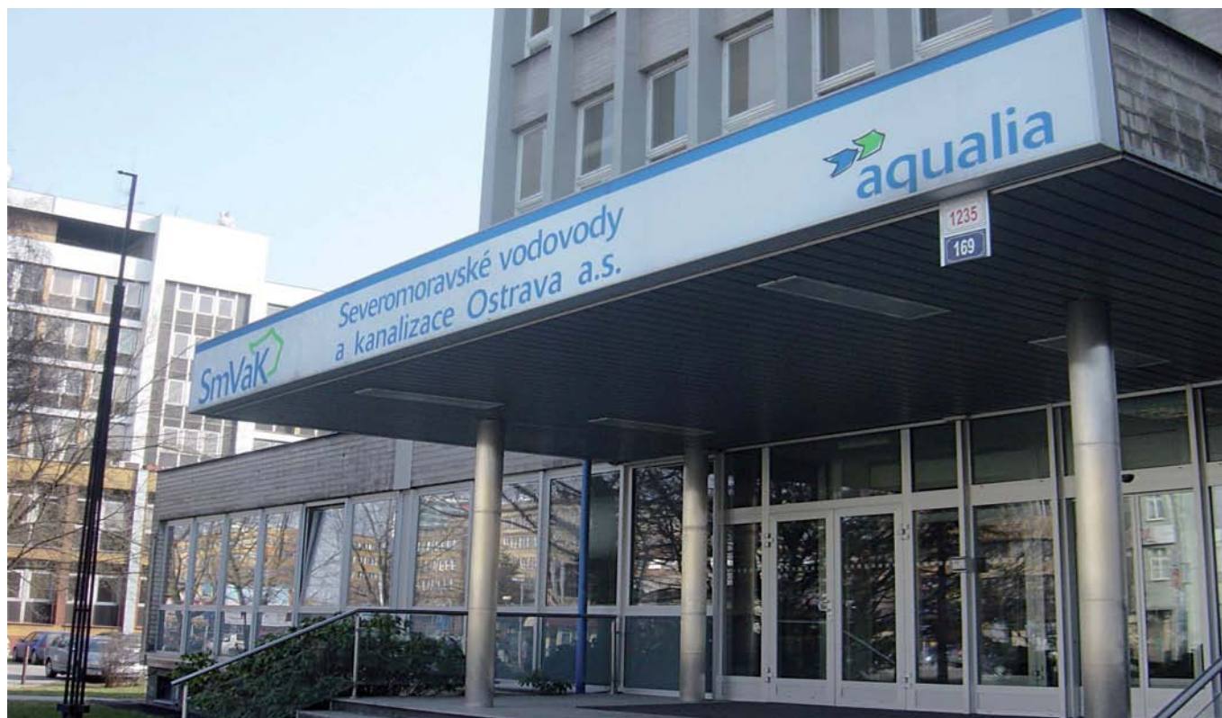
Oficinas centrales de SmVaK, Ostrava. República Checa
