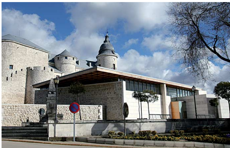
Rehabilitación del Archivo de Simancas. Salamanca
