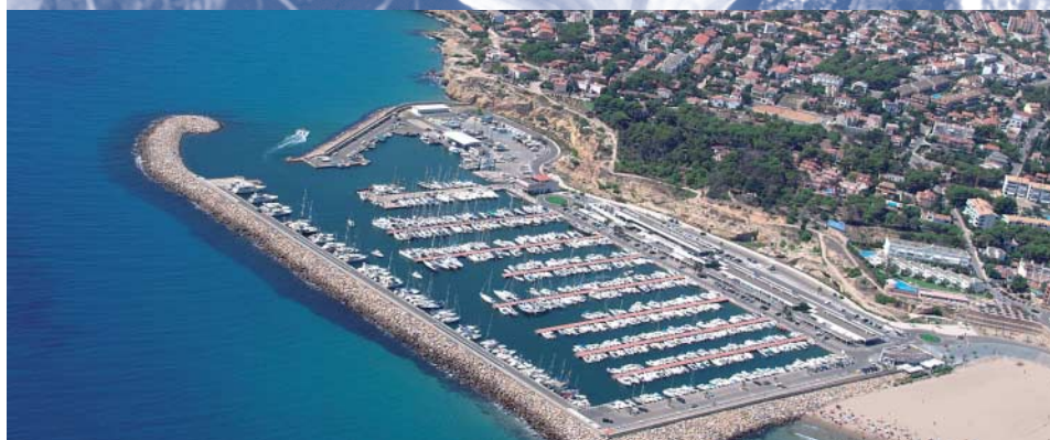
Puerto de Torredembarra. Tarragona
