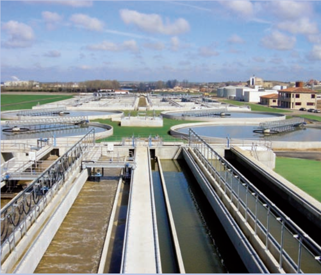
Estación depuradora de aguas residuales. Salamanca
