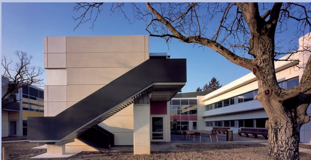
Centro de disminuidos psíquicos. Pamplona. Navarra
