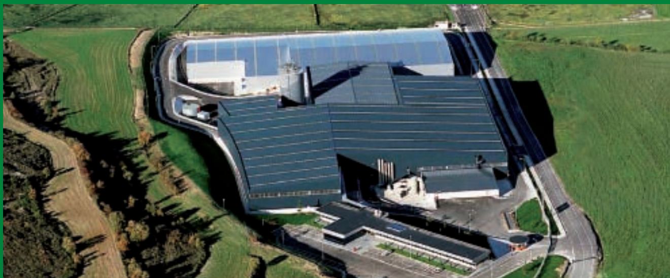
Planta de tratamiento de residuos. Jundiz. Vitoria
