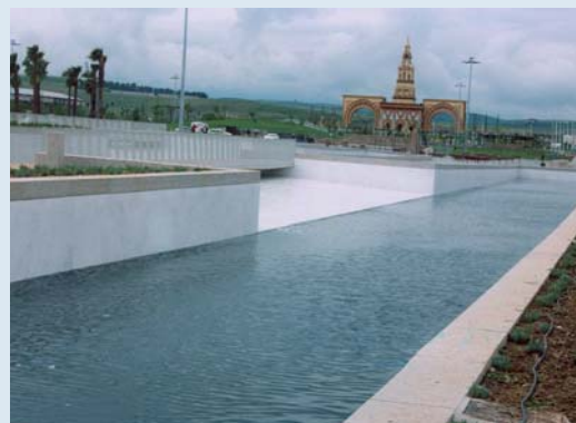
Urbanización El Balcón del Guadalquivir. Córdoba
