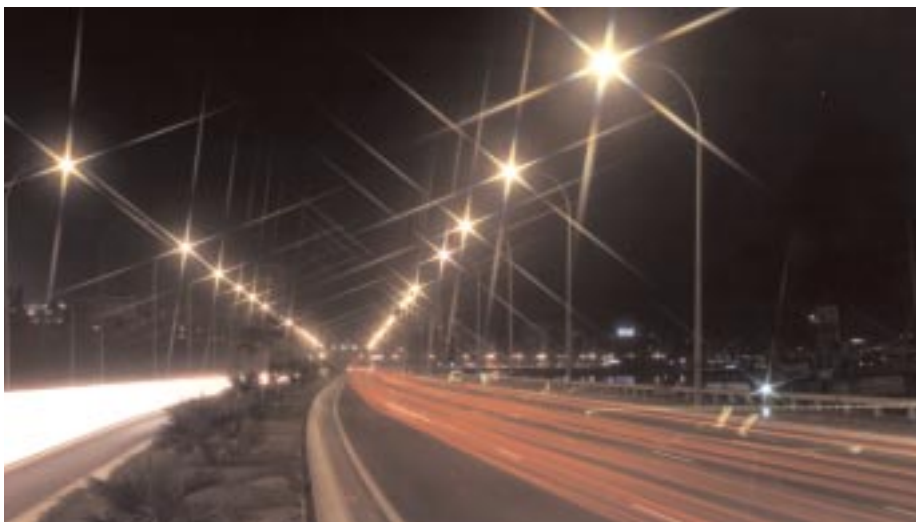
■ Iluminación de la Radial 3. Madrid
