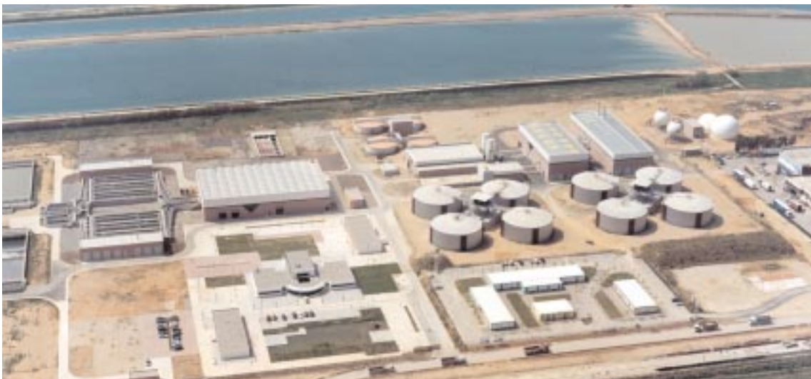
■ Edar Depurbaix. Barcelona
