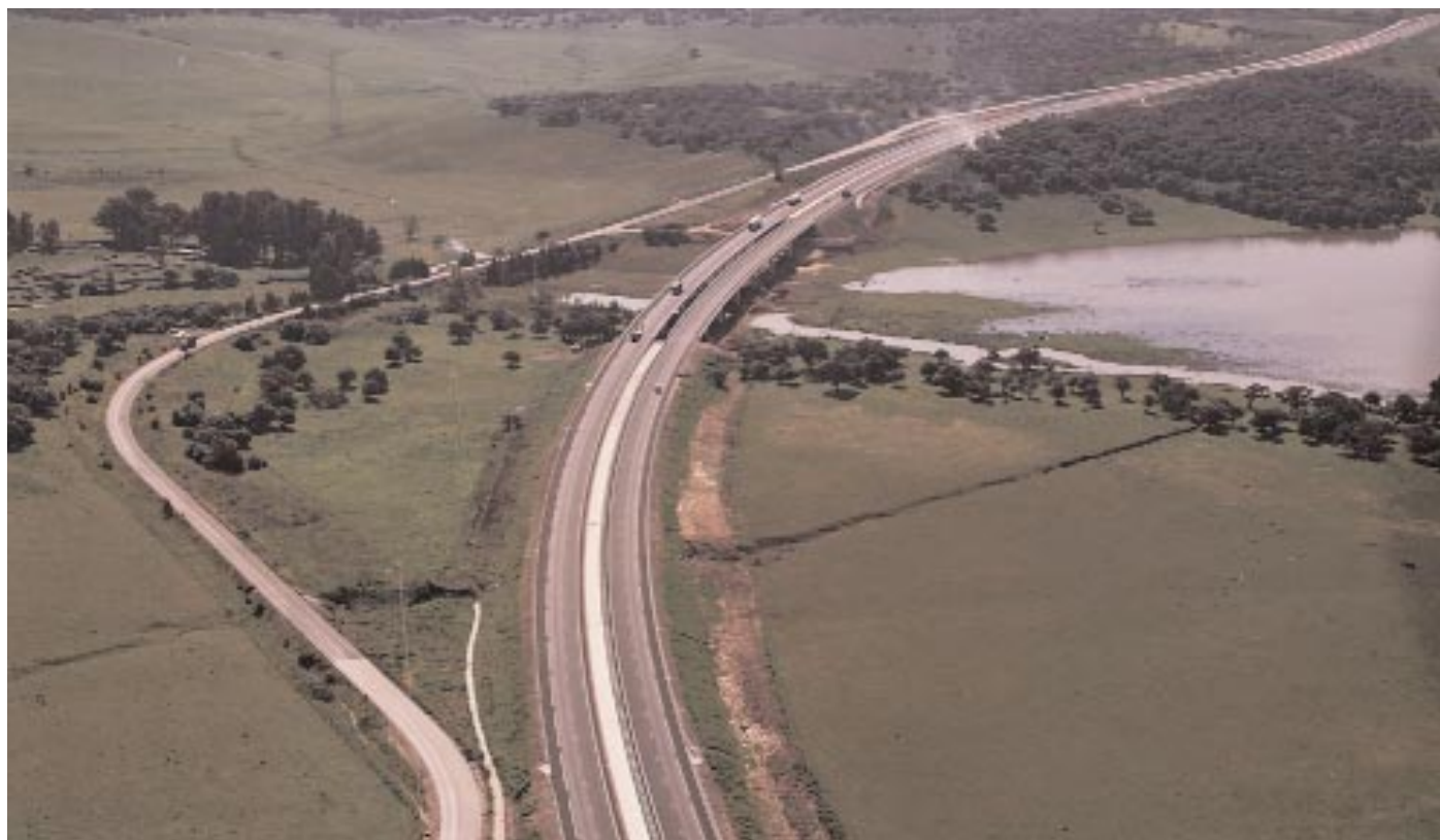
■ Autovía A-381, Jerez-Los Barrios
