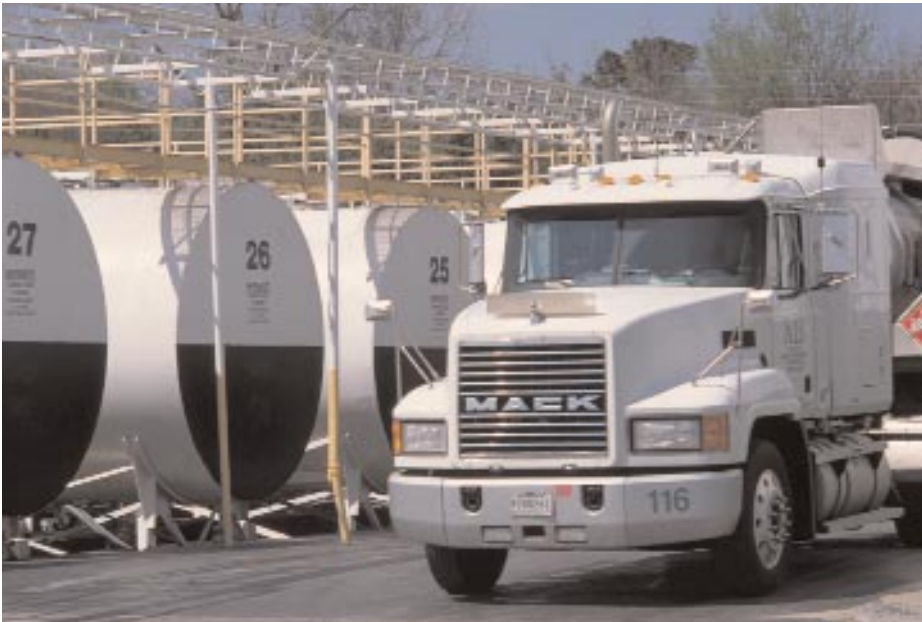
Planta de tratamiento de residuos. Carolina del Sur. EE.UU.
