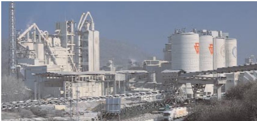
Fábrica de cemento. Olazagutía. Navarra
