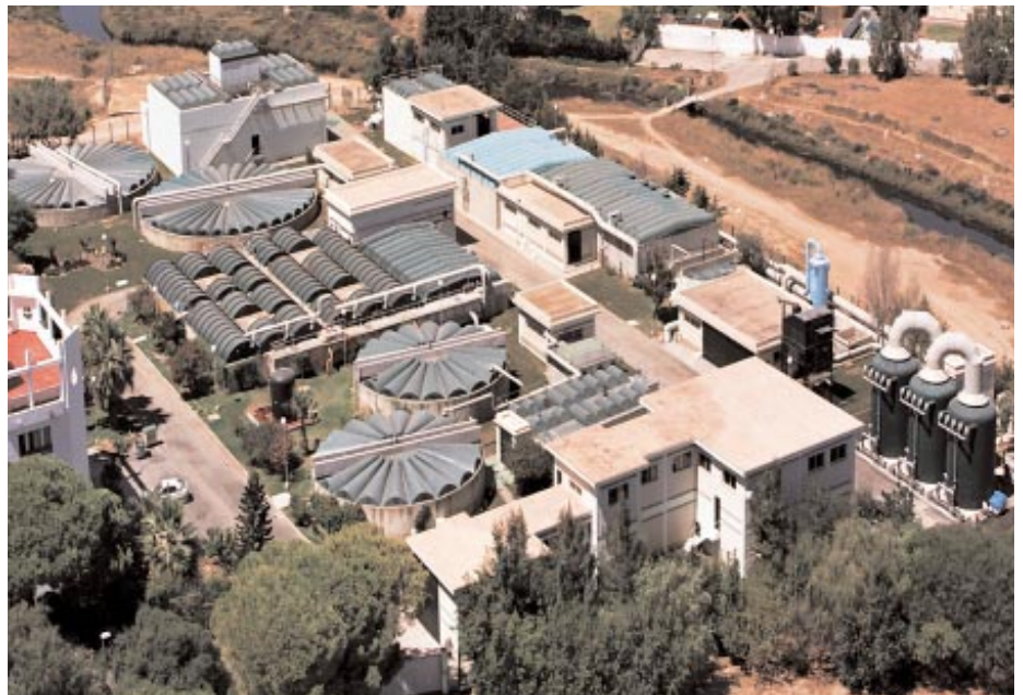
■ Estación depuradora en Chiclana. Cádiz
