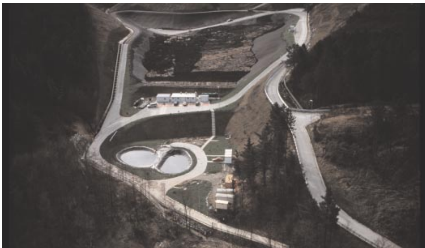
■ Vertedero de residuos industriales. Bisbieta. Bilbao
