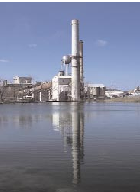
Fábrica de cemento en Keystone. EE.UU.
