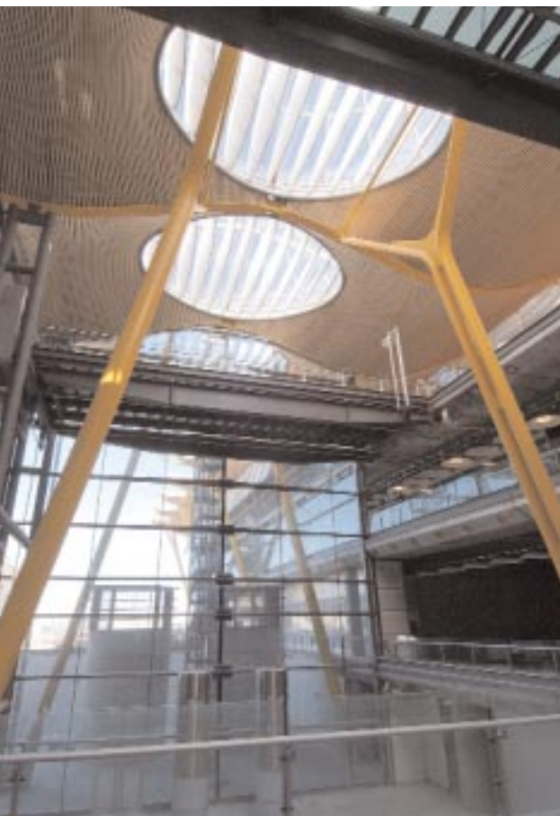
■ Edificio terminal del aeropuerto Madrid. Barajas
