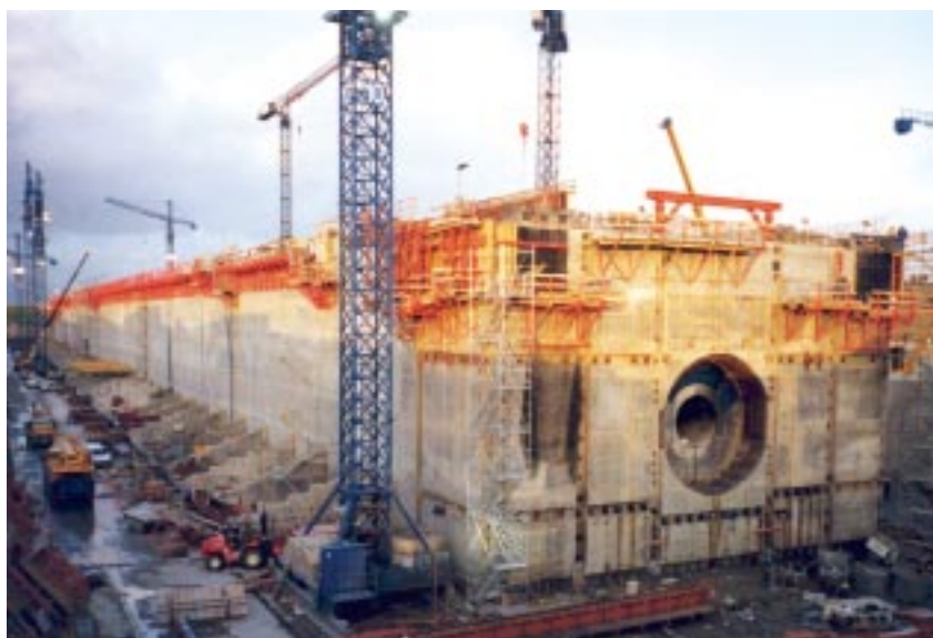
Dique flotante para el puerto de Mónaco
