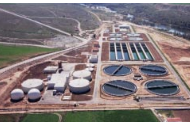
Estación depuradora de aguas residuales. Salamanca
