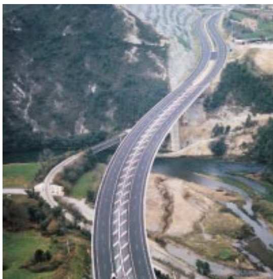
Autovía del Cantábrico, CN-632. Tramo Caravia-Llovio. Asturias
