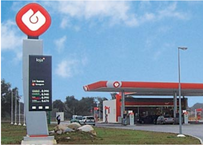
Estación de servicio Galp. Portugal
