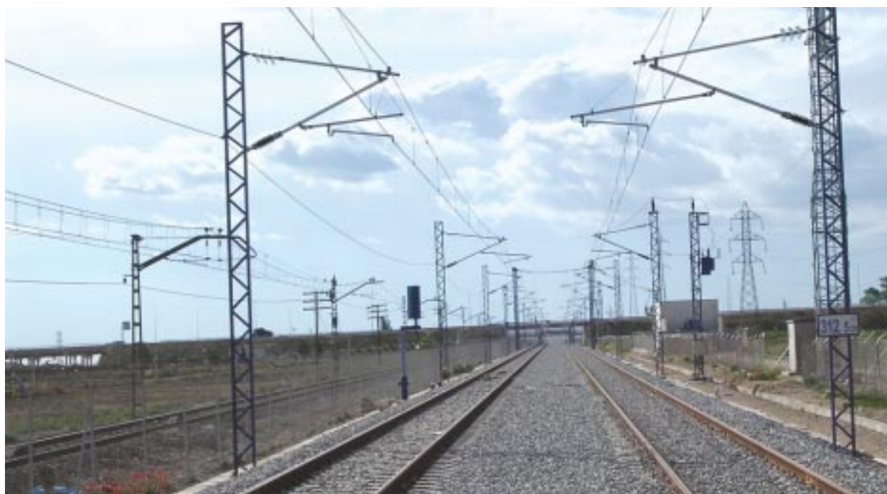
Montaje de vía de alta velocidad en el tramo Zaragoza-Pina de Ebro
