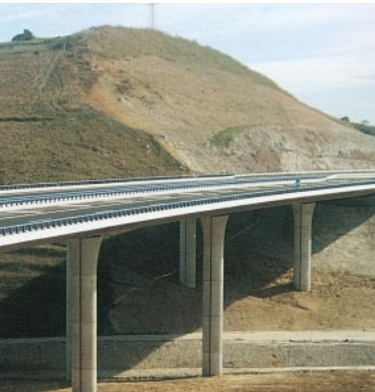
Viaducto el Acebo en la autovía del Cantábrico. Asturias
