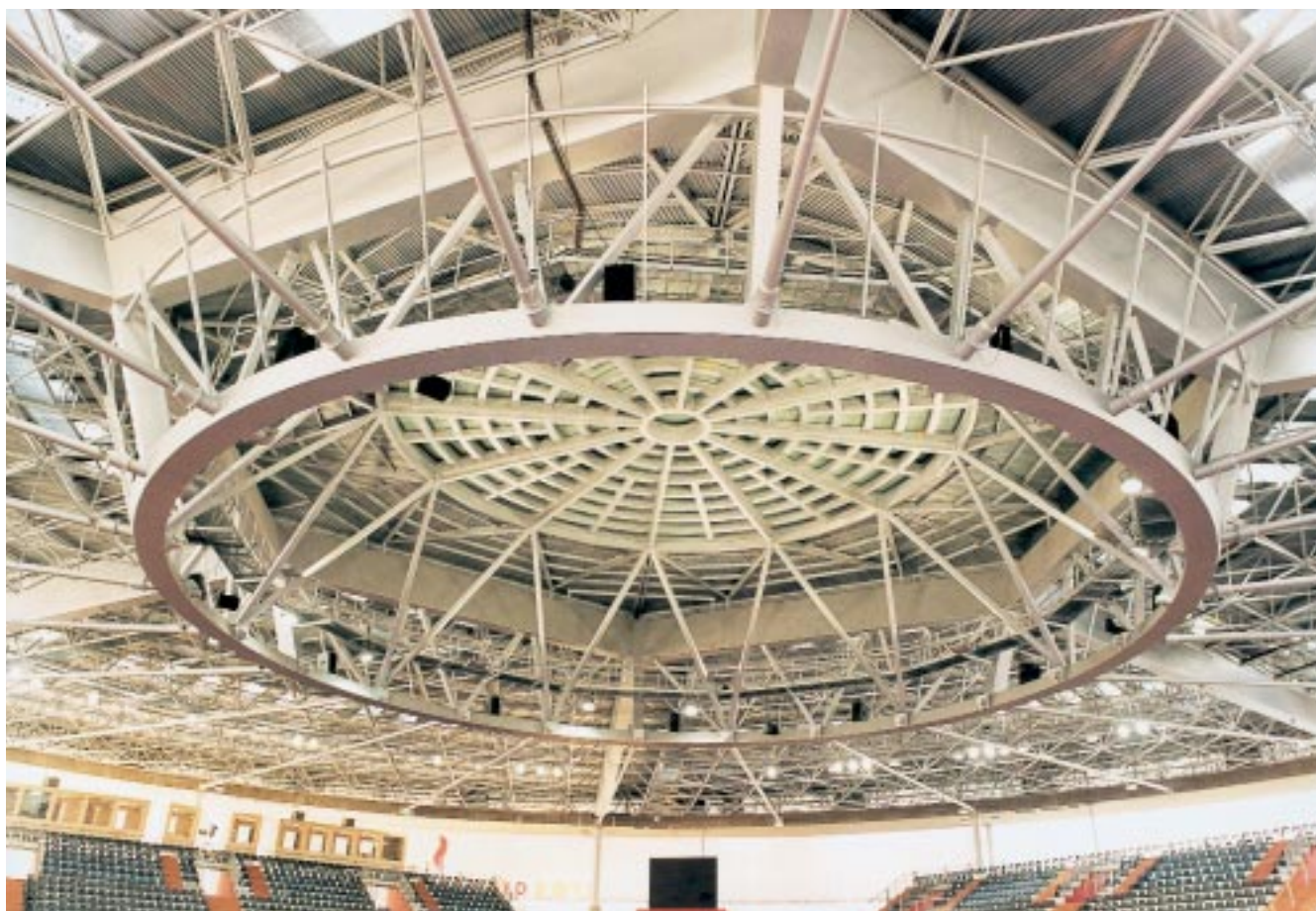
Cubierta del Rockódromo de la Casa de Campo. Madrid
