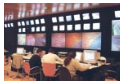
Patio de operaciones de la gestión del tráfico de Barcelona
