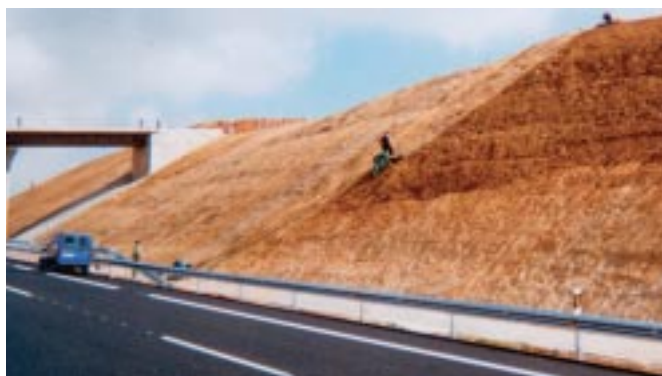
Colocación de manta orgánica en taludes de la autopista Ávila-Villacastín
