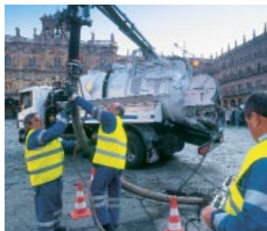
Servicio de limpieza del alcantarillado de Salamanca
