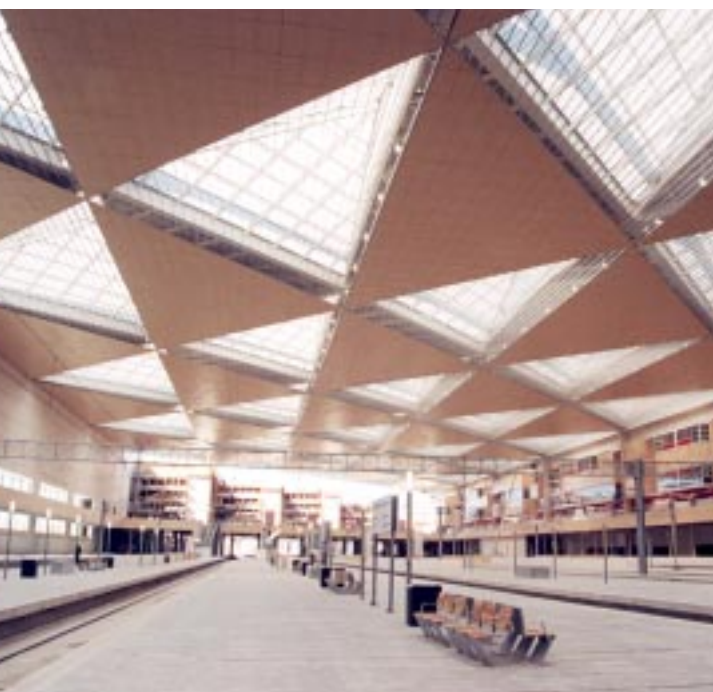
Cubierta de la estación Zaragoza-Delicias del AVE
