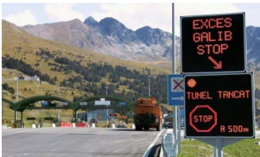
Señalización en el túnel de Envalira. Andorra
