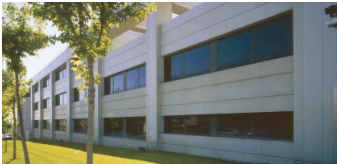
Edificio Amper. Tres Cantos. Madrid
