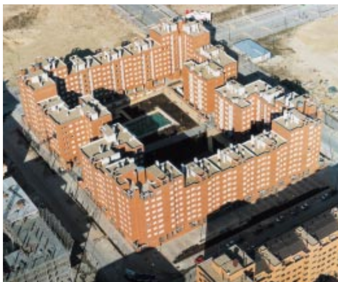
Viviendas en Vicálvaro. Madrid
