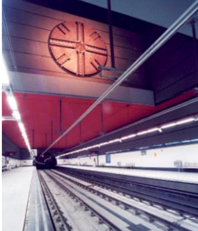
Metrosur. Intercambiador de Móstoles. Madrid
