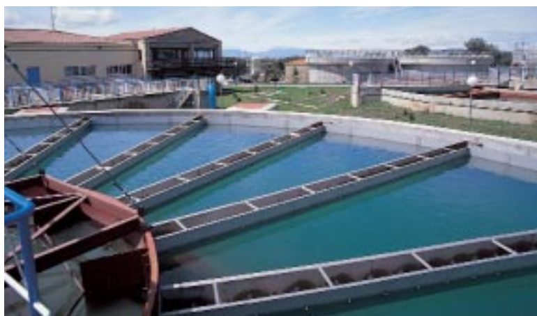
Estación de tratamiento de agua potable. Ávila
