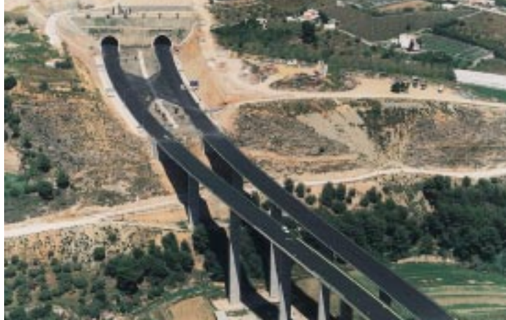
Viaducto del Chillar y embocadura de los túneles de Capistrano. Tramo Frigiliana-Nerja. Málaga
