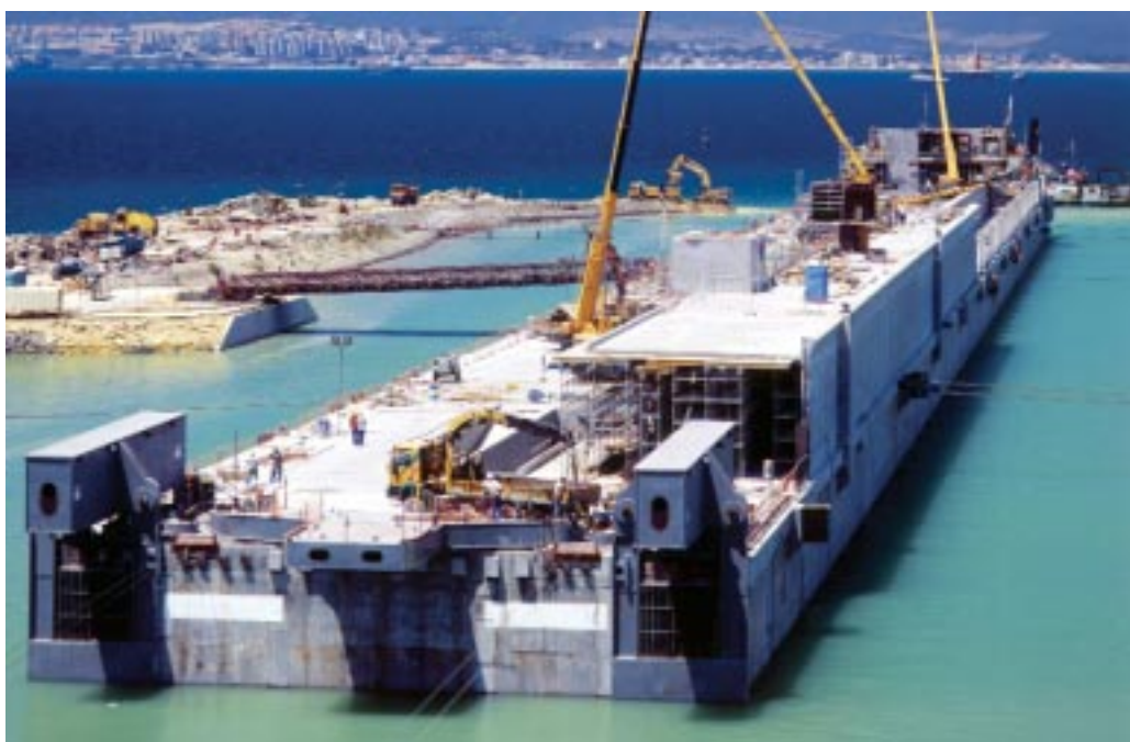
Dique flotante construido en Algeciras, Cádiz, para el puerto de Mónaco
