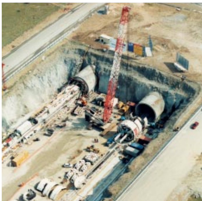
Túneles de Guadarrama. Conexión ferroviaria de alta velocidad entre Madrid y el norte y noroeste de España
