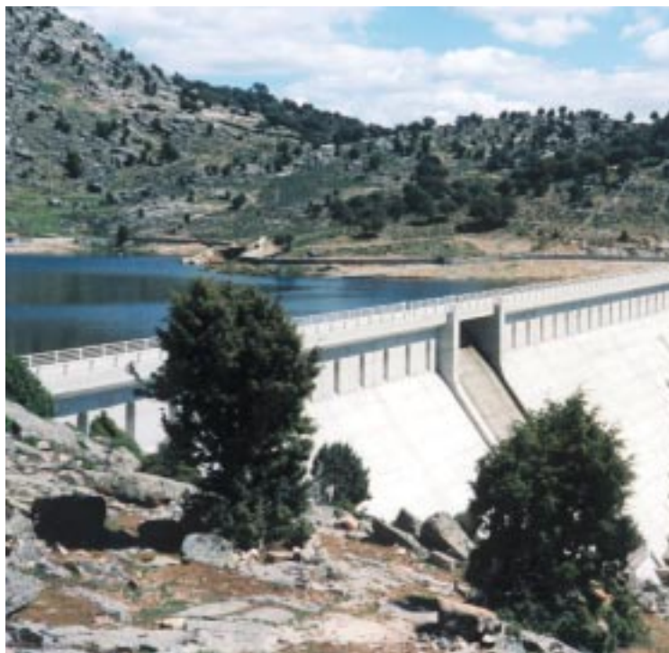
Presa de Santa Cruz de Pinares. Ávila
