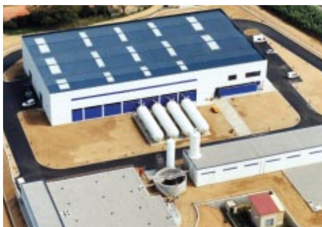
Desaladora de Blanes. Girona
