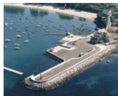
Dique flotante y pantanones en el refugio de Aguete. Pontevedra
