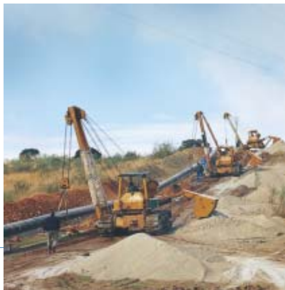
Gasoducto Rivas-Alcalá (Madrid).
