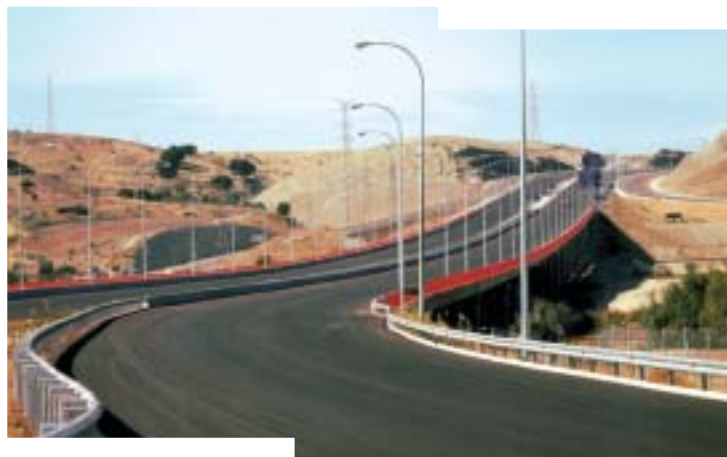
Viaducto del Jarama en la M-45.
