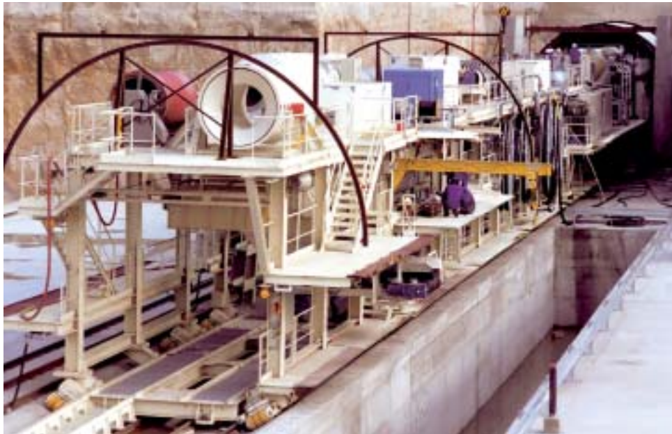
Tuneladora "La Adelantada".
