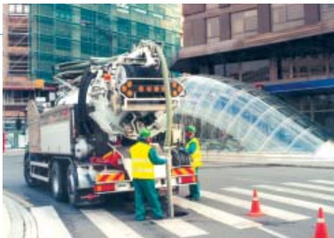
Limpieza de alcantarillado. Bilbao.
