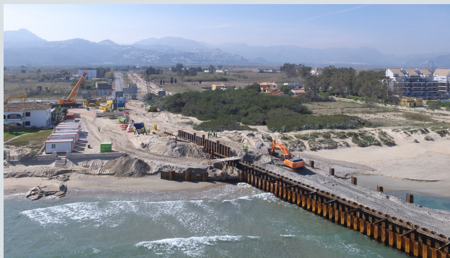
Denia Landfall 3. Gasoducto submarino
