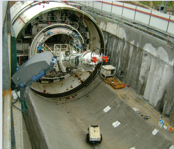
Tuneladora túnel Ave-Atocha-Chamartín (Madrid)
