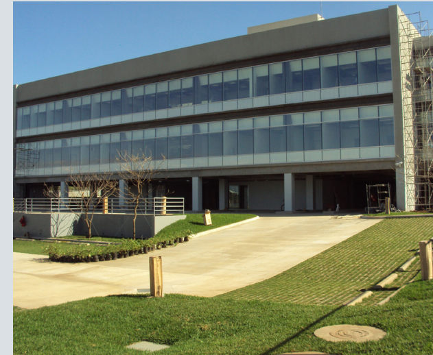
Edificio oficinas BID Nicaragua
