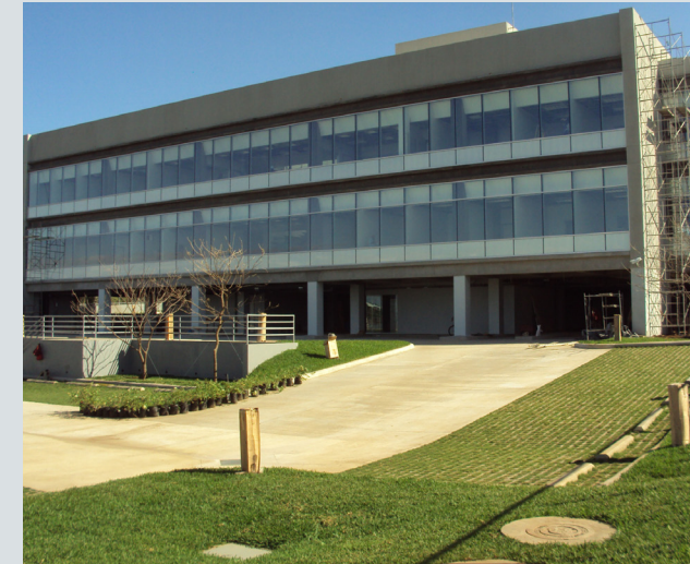
Edificio oficinas BID Nicaragua
