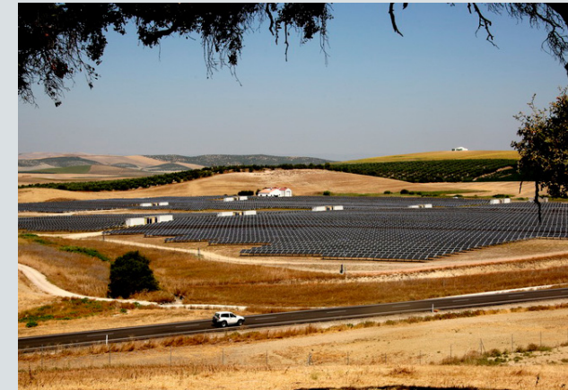
Planta fotovoltaica en Córdoba
