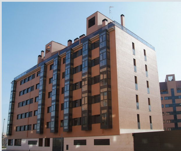
Viviendas área norte, Las Tablas (Madrid)
