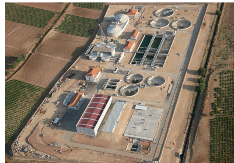
Wastewater treatment plant in Tomelloso, Ciudad Real
