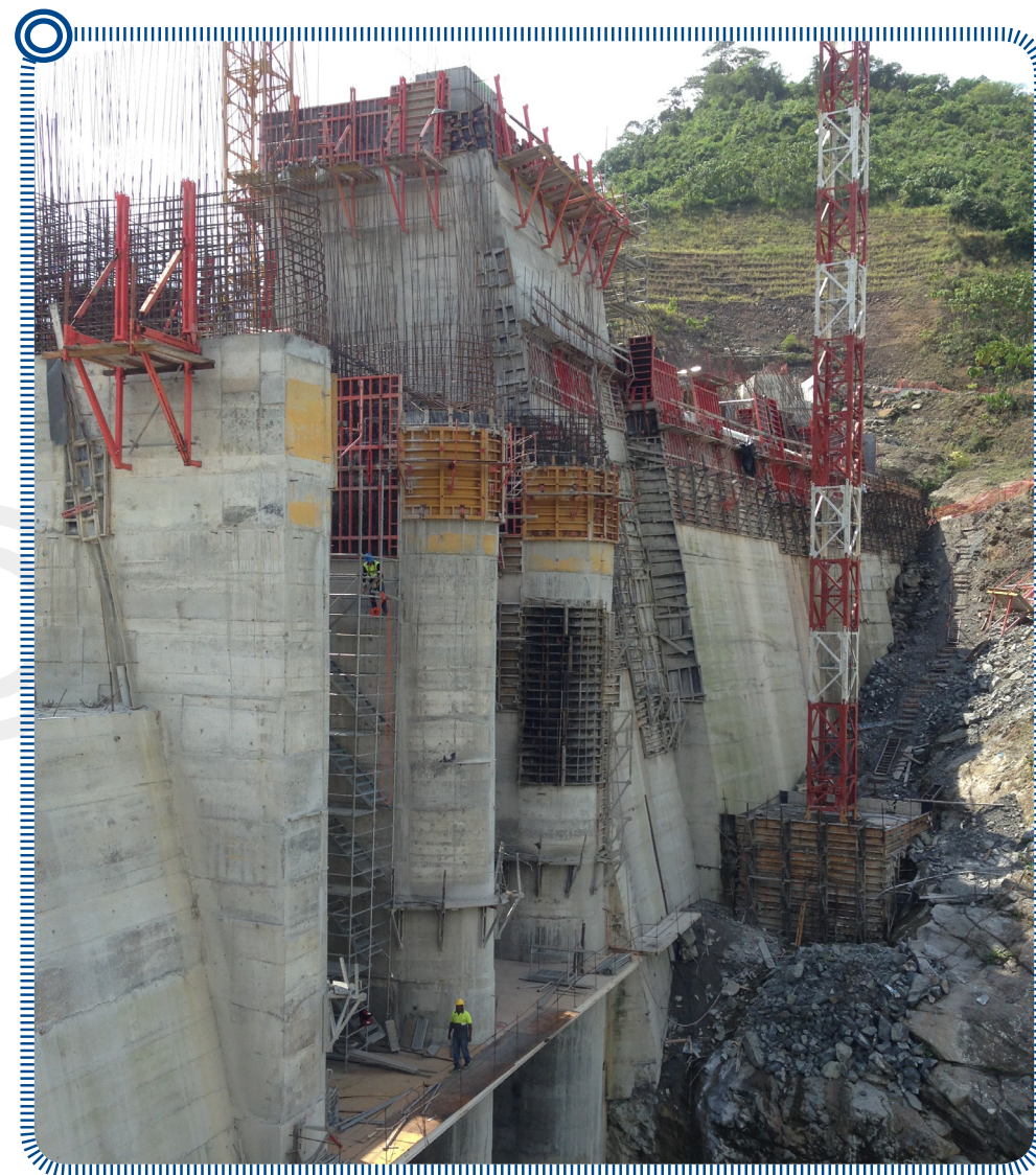
Bajo Frío Dam in Panama
