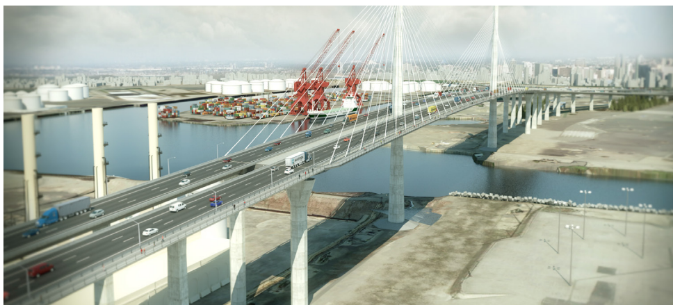
Gerald Desmond Bridge. Los Angeles (USA).
