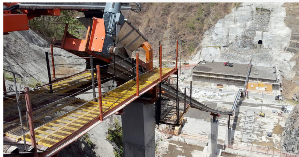
Chucás Dam (Costa Rica).
