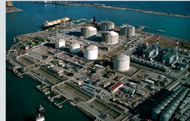
Enagás plant, Barcelona
