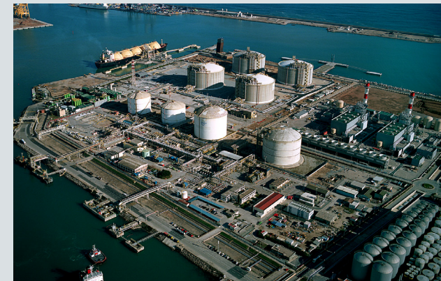
Enagás plant, Barcelona
