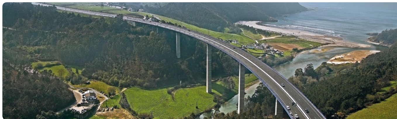
CANERO BRIDGE, ASTURIAS.
