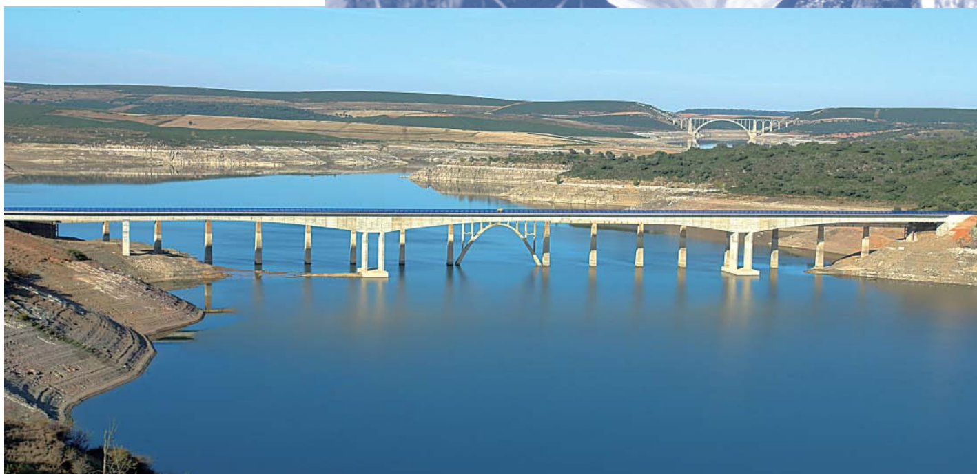
El Manzanal Bridge. Zamora
