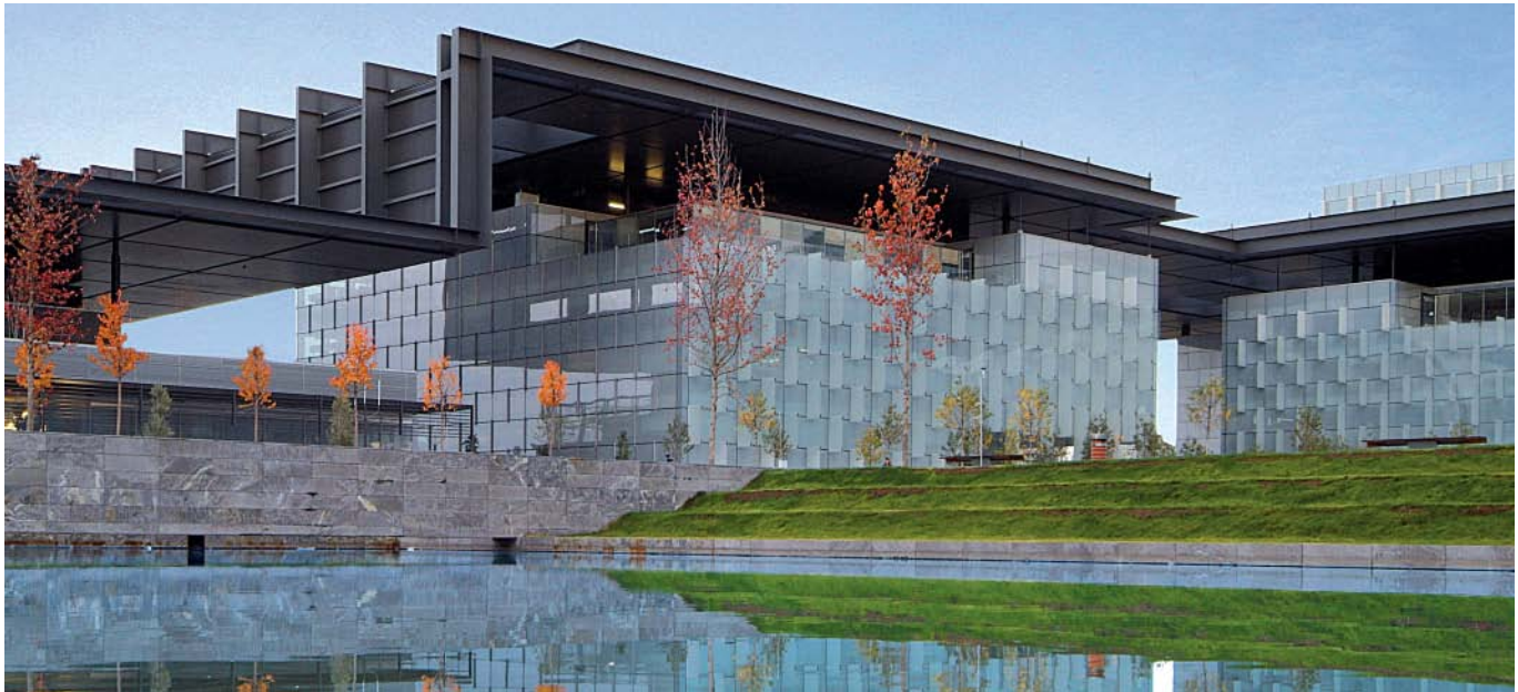
Telefónica's Communications City in Las Tablas, Madrid
