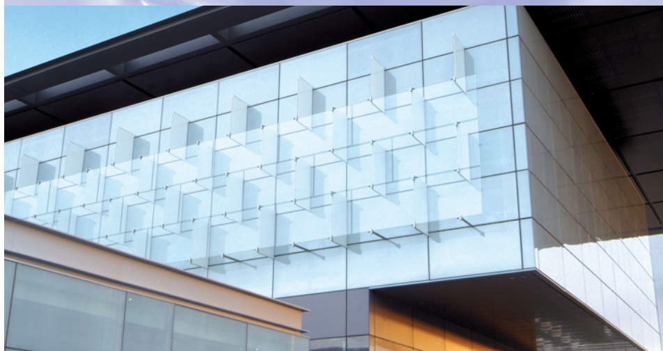
Telefónica Communications City. Las Tablas. Madrid
