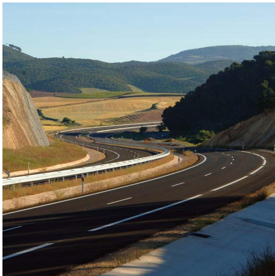
Autovía del Camino. Pamplona-Logroño
