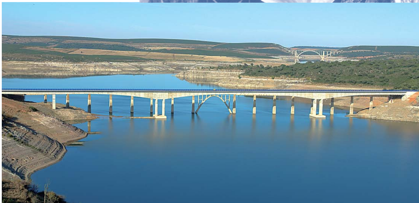
El Manzanal Bridge. Zamora
