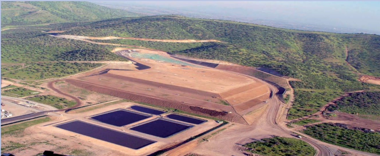
Proactiva. Controlled landfill. Chile
