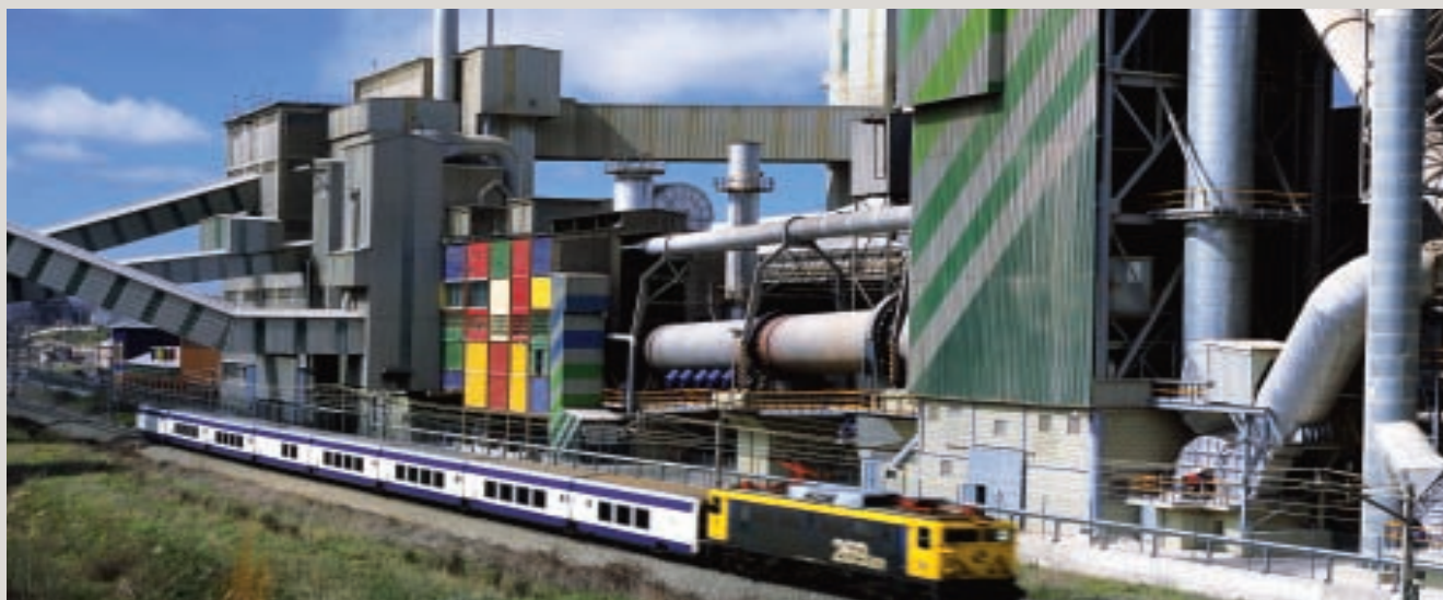
Factory in Mataporquera. Cantabria
