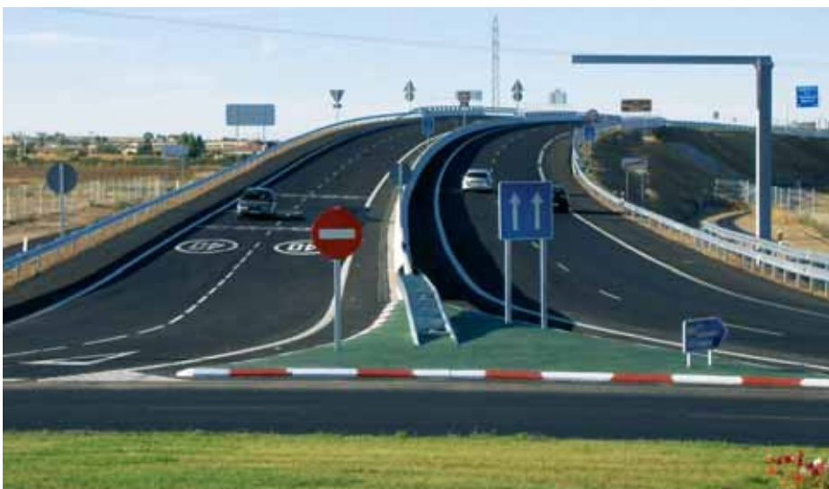
Autovía del Duero dual carriageway Toro-Zamora section
