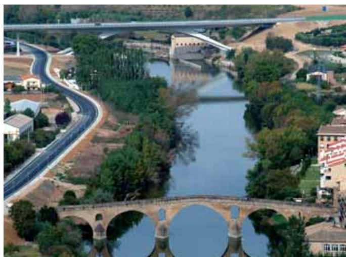
Autovía del Camino dual carriageway. Navarra
