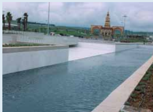
Urbanisation El Balcón in Guadalquivir. Córdoba
