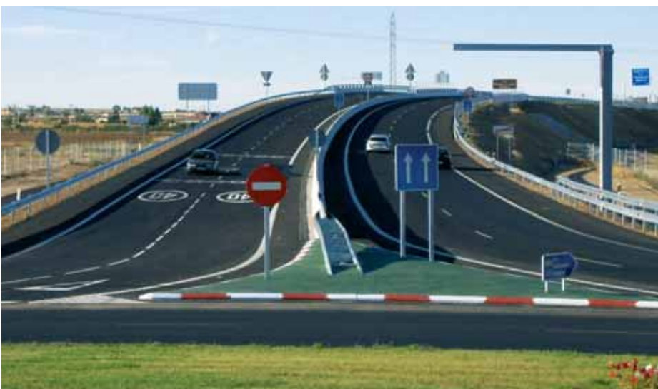
Autovía del Duero dual carriageway Toro-Zamora section
