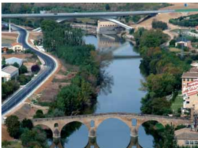
Autovía del Camino dual carriageway. Navarra
