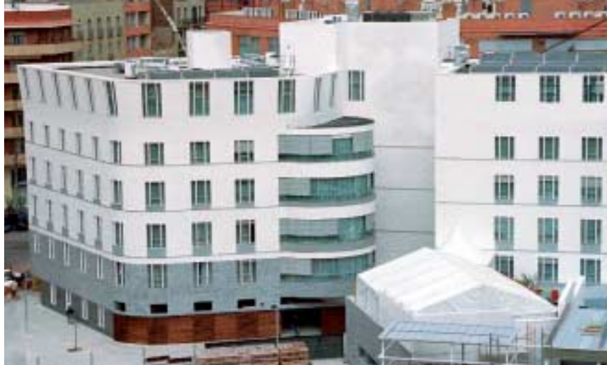
Ayuda al Desvalido Foundation. Barcelona
