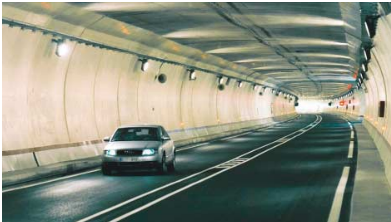
Túnel d'Envalira. Andorra
