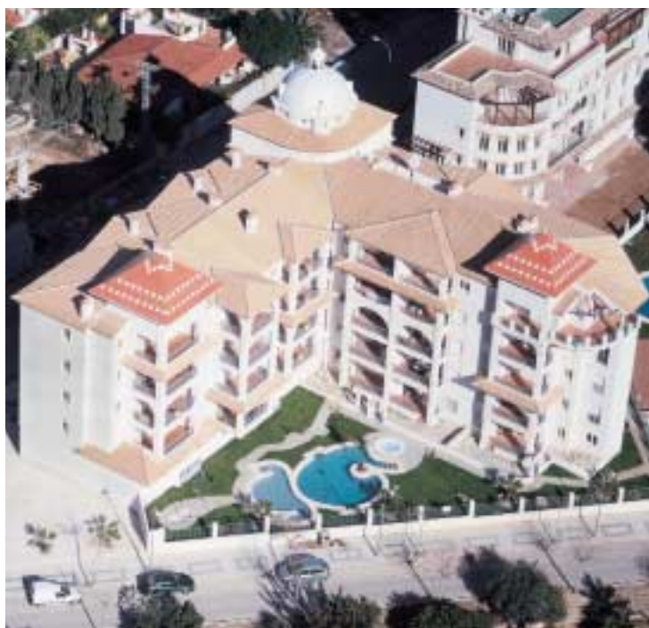
La Rotonda housing estate, Alfaz del Pi. Alicante
