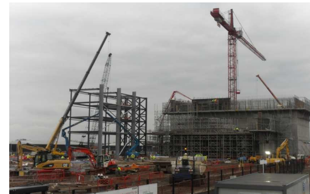
Avance de construcción (Febrero 2012)
