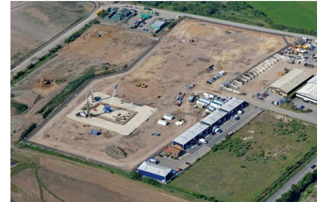
Inicio de obras (Junio 2011)
