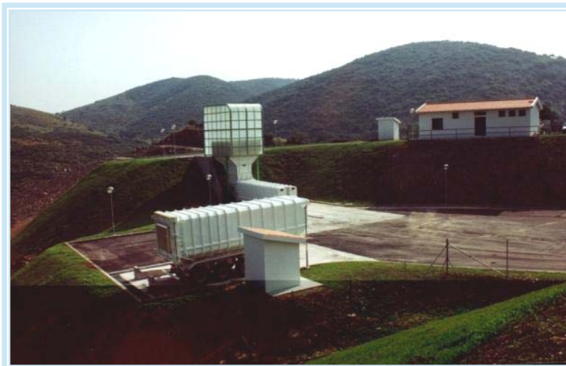
Estación de transferencia -Torre de Moncorvo (Portugal)
