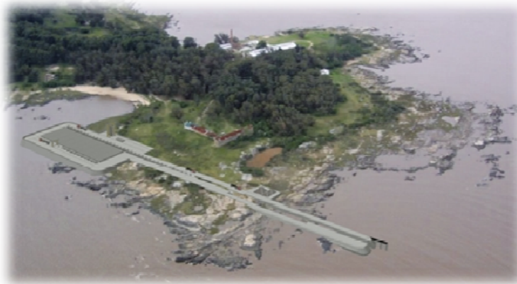
Transmarine pipeline (Uruguay)
