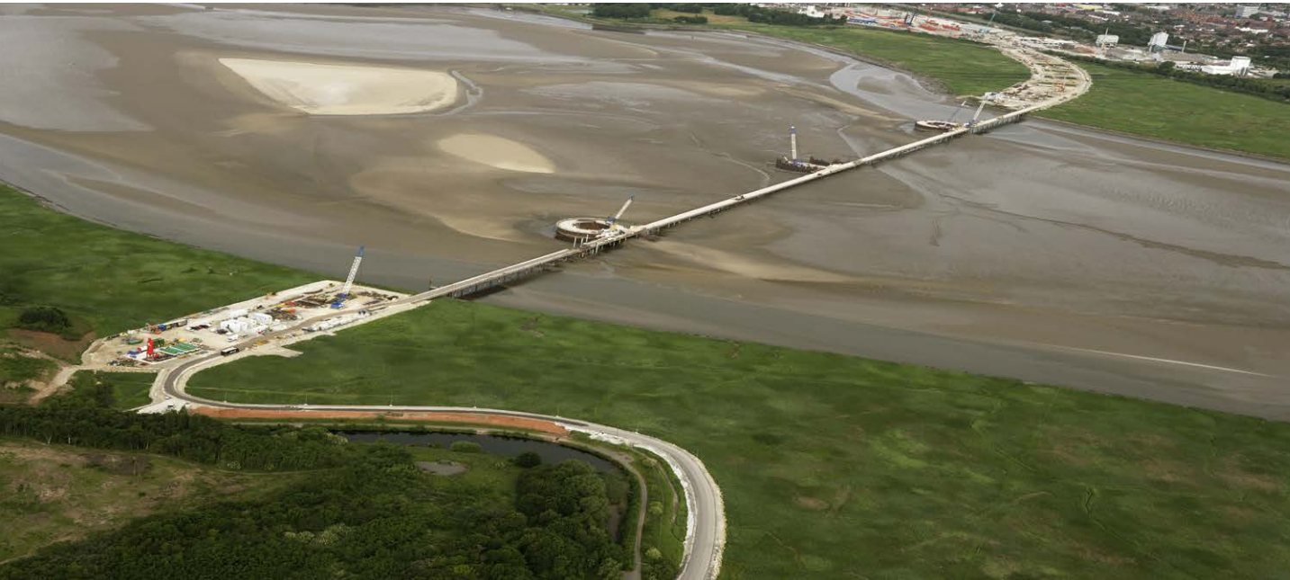
Viaducto de Mersey (Reino Unido).
