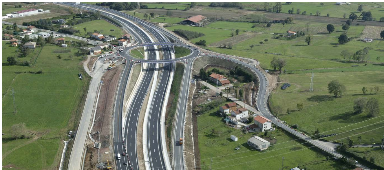
Autovía A-8. Tramo Solares-La Encina, Cantabria (España).
