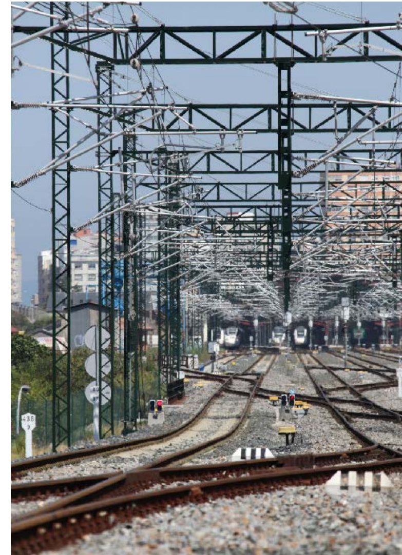
Catenaria del Eje Atlántico para ADIF (España).
