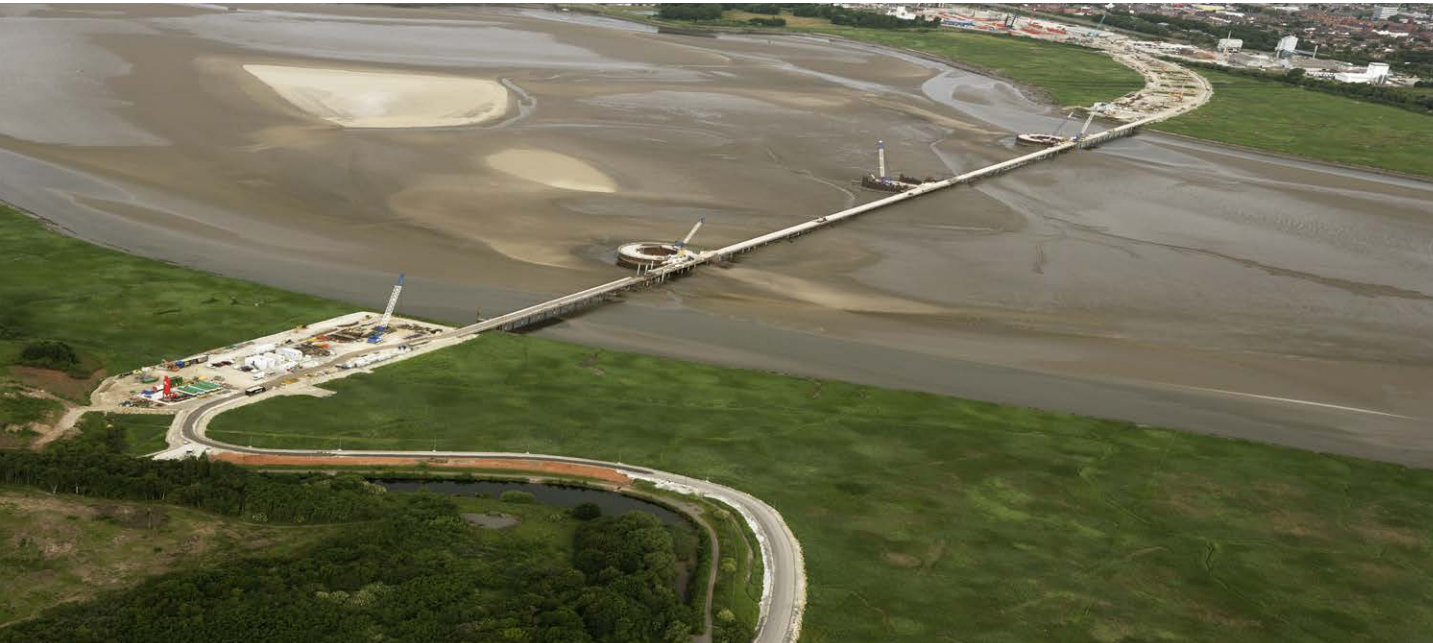
Viaducto de Mersey (Reino Unido).
