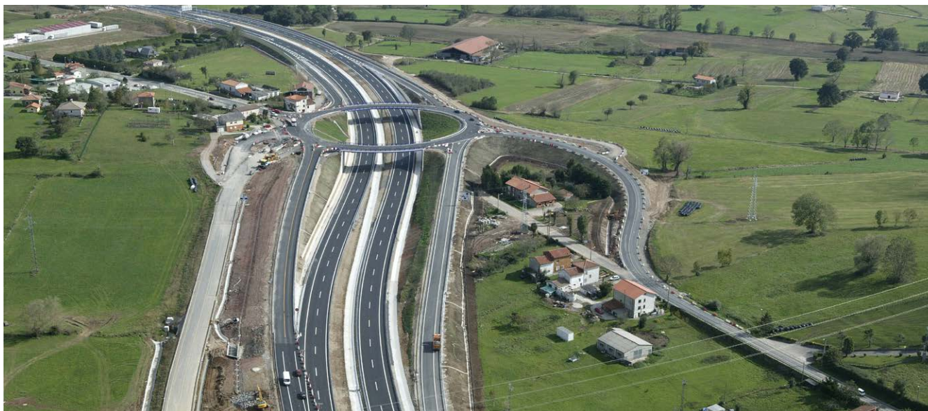
Autovía A-8. Tramo Solares-La Encina, Cantabria (España).
