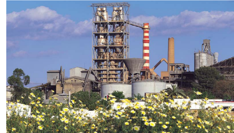
Alcalá de Guadaira Plant, Seville (Spain).
