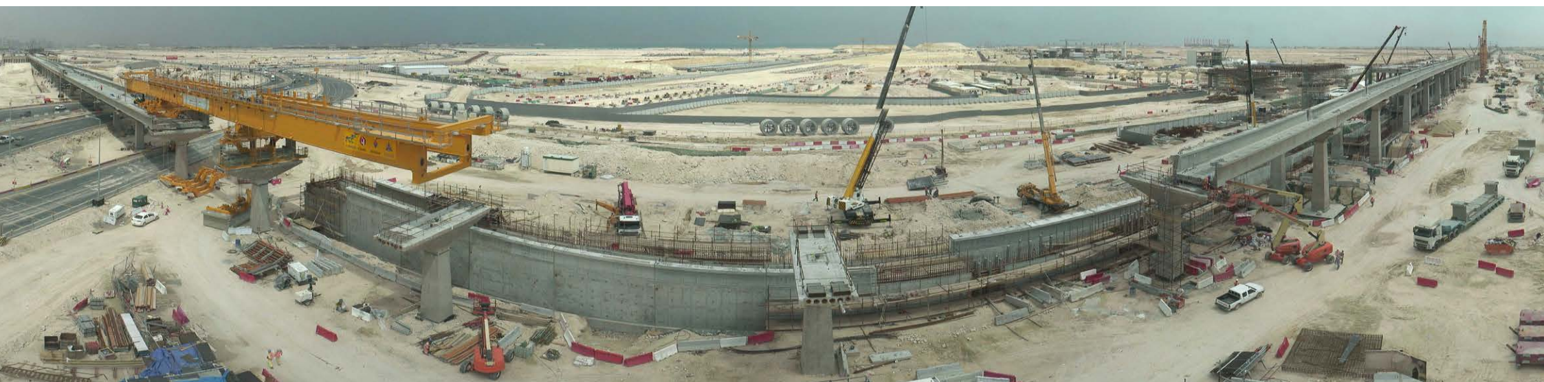
Doha Metro (Qatar).
